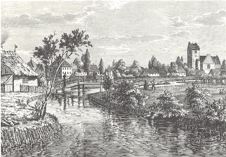
Mølleåen set fra jernbanedæmningen mod Lyngby. Forrest »Aalykke«s store engarealer, hvor der vaskedes og blegedes tøj (jfr. manden ved broen). I baggrunden til venstre ses landstedet »Hollandia« med maskinværkstedets karakteristiske terningformede bygning med det spidse tag. Træsnit af Carl Emil Baagøe 1869.
