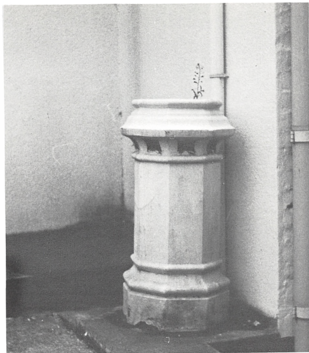
Fig. 2. Nedtaget chimney til blomster. Hotel Danmark i Marstal
