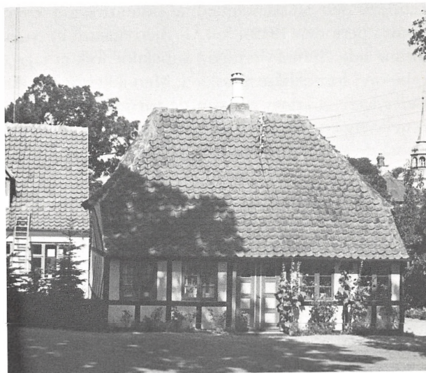
Fig. 3. En chimney i Ærøskøbing, direkte på en sokkel.
