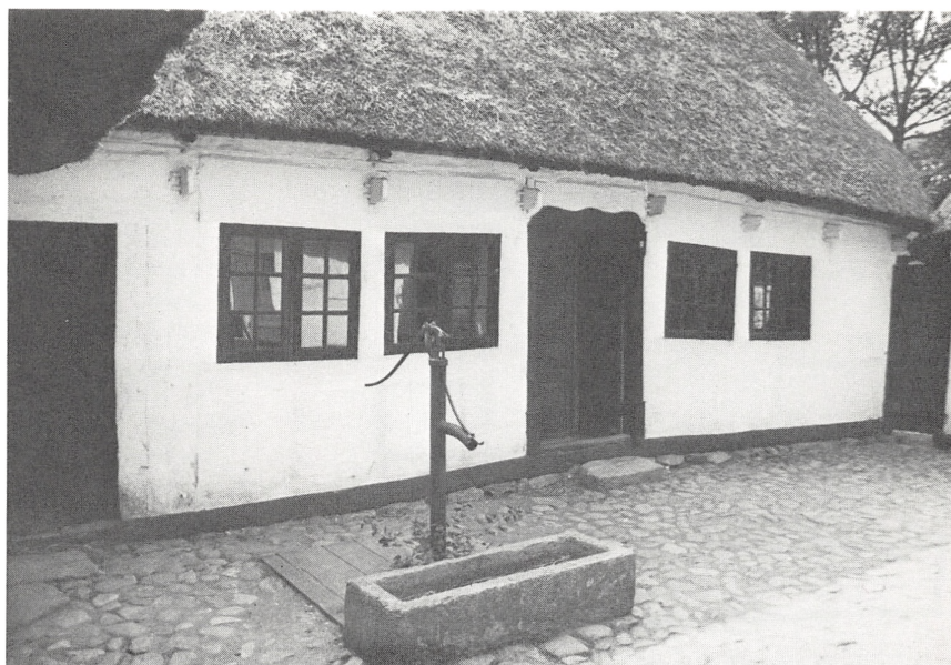
Fig. 7. Stuehusets nordfacade og gårdspladsen med vandpost og drikketrug. E. Hedegaard foto 1983.
