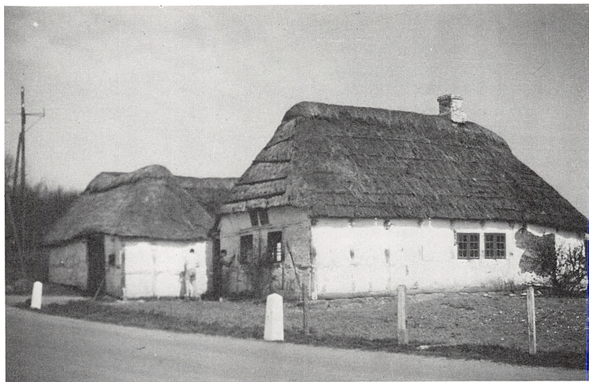
Fig. 1. Melby-huset, set fra syd, under opmålingen i 1948. Stuehusets stråtag er »simbare«, dvs. så slidt af vejrliget, at tækkæppene bliver synlige. På gavlens valmtag er der endda lagt nogle lægter for at holde på stråene. E. Hansen foto.
