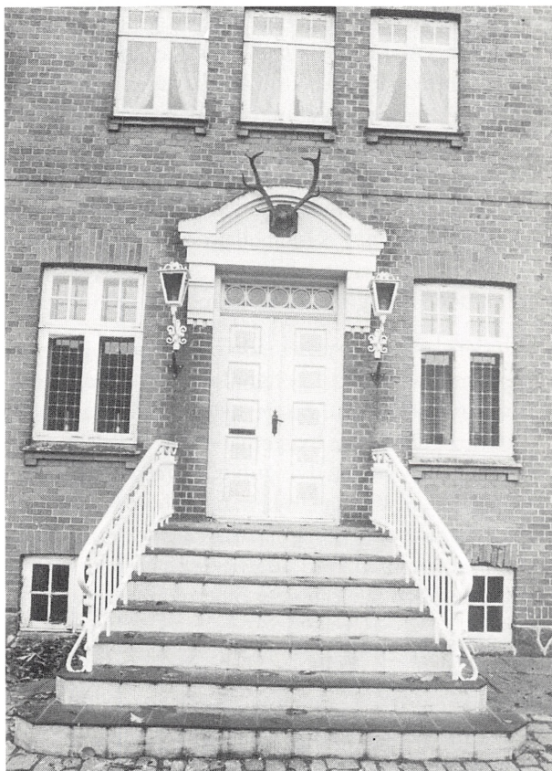
b. Indgangspartiet til stuehuset.
