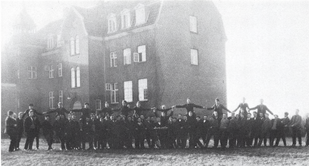
Arbejderhøjskolen for tilbygningen i 1929.
