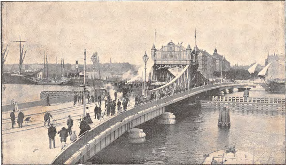
Jernbanevogne, belæsset med Sten, passerer Langebro for at prøve Broens Eæreevne. (Fot. Carl E. Aagaard.)
