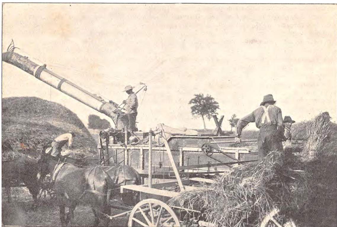
Tærskning paa Marken (Avnerne blæses ud gennem det lange Rør).
