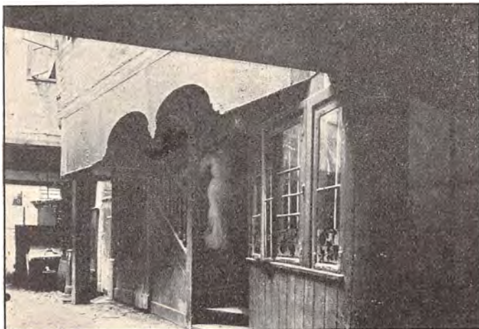
Port med udvendig Trappe, Pilestræde 10.
