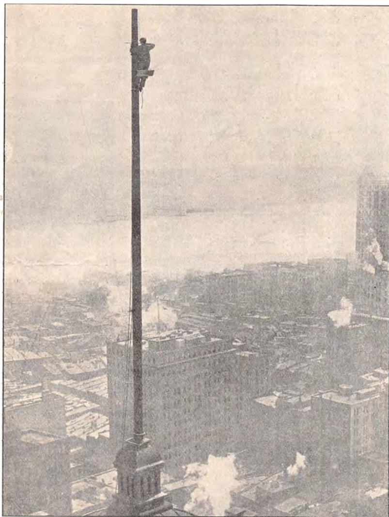
Den 60 Fod høje Flagstang paa en New Yorker Skyskraber saves af i fire Fod lange Stykker fra oven af. Man kunde ikke save den af ved Grunden af Frygt for Ulykker.
