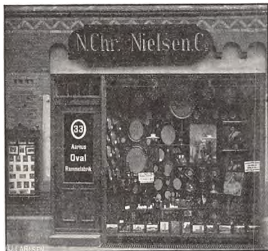
Aarhus Oval Rammefabrik.
