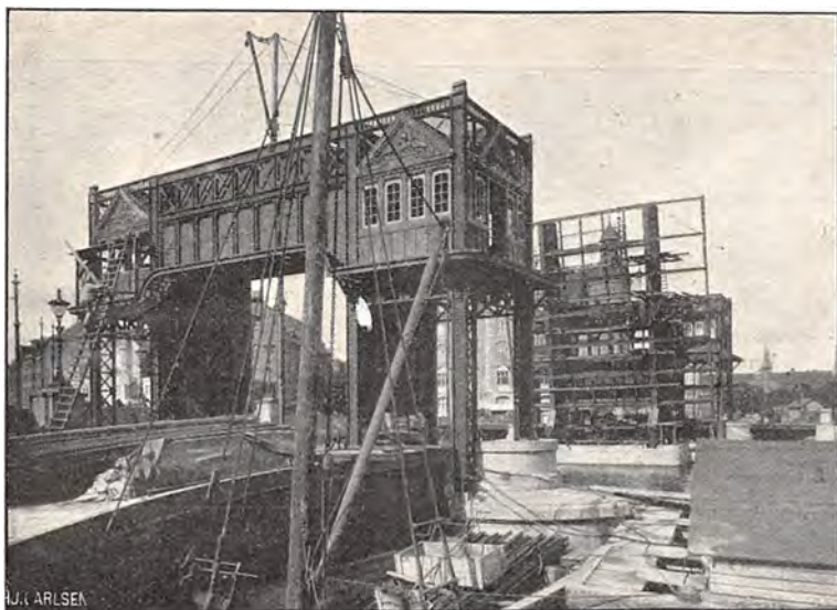
Den nye Knippelsbro, der nu har faaet Broklapperne paasat. Jul. Aagaard' fot
