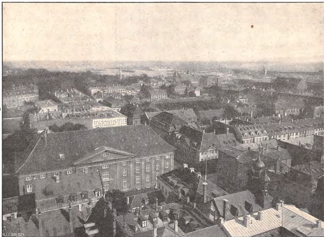
Fra Marmorkirkens Kuppel mod Nordøst. Der er ingen Fabriksskorstene, det er et velhavende Kvarter. I Forgrunden Rigsdagen. Jul. Aagaard fot.
