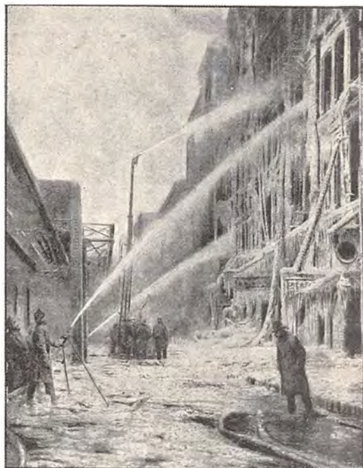
Amerikanske Brandmænd ved en Brand i en haarde Vinter. Medens Flammerne raser inde i Bygningen, stivner Vandet til Is udenpaa Muren.
