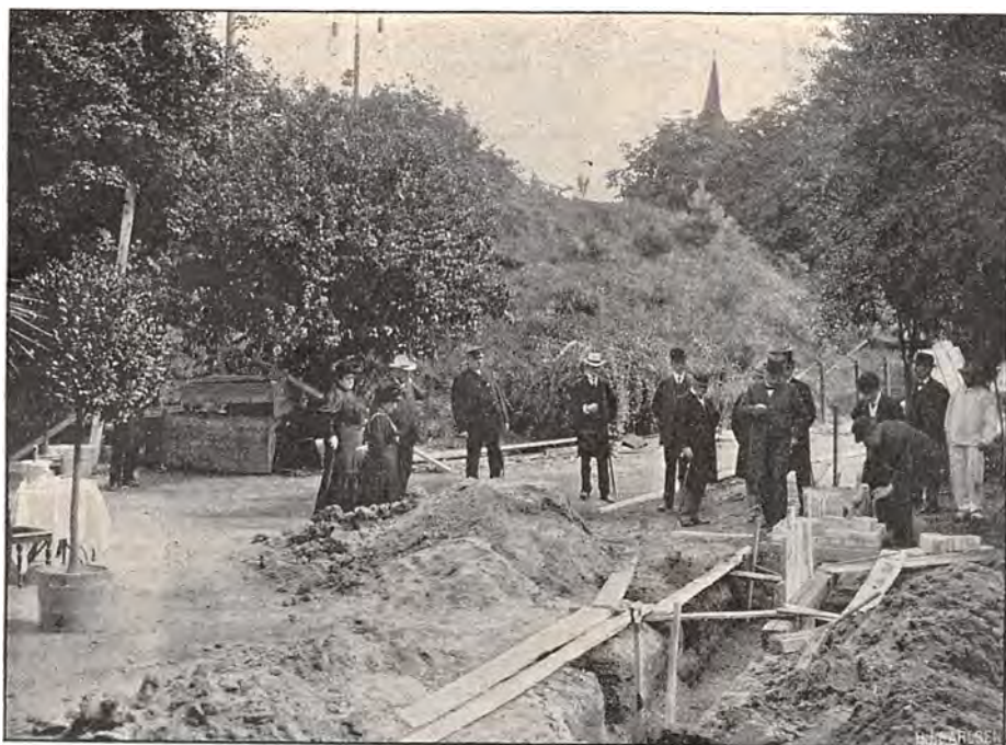
Grundstensnedlæggelsen til den nye Basarbygning i Tivoli. H. Stender fot.
