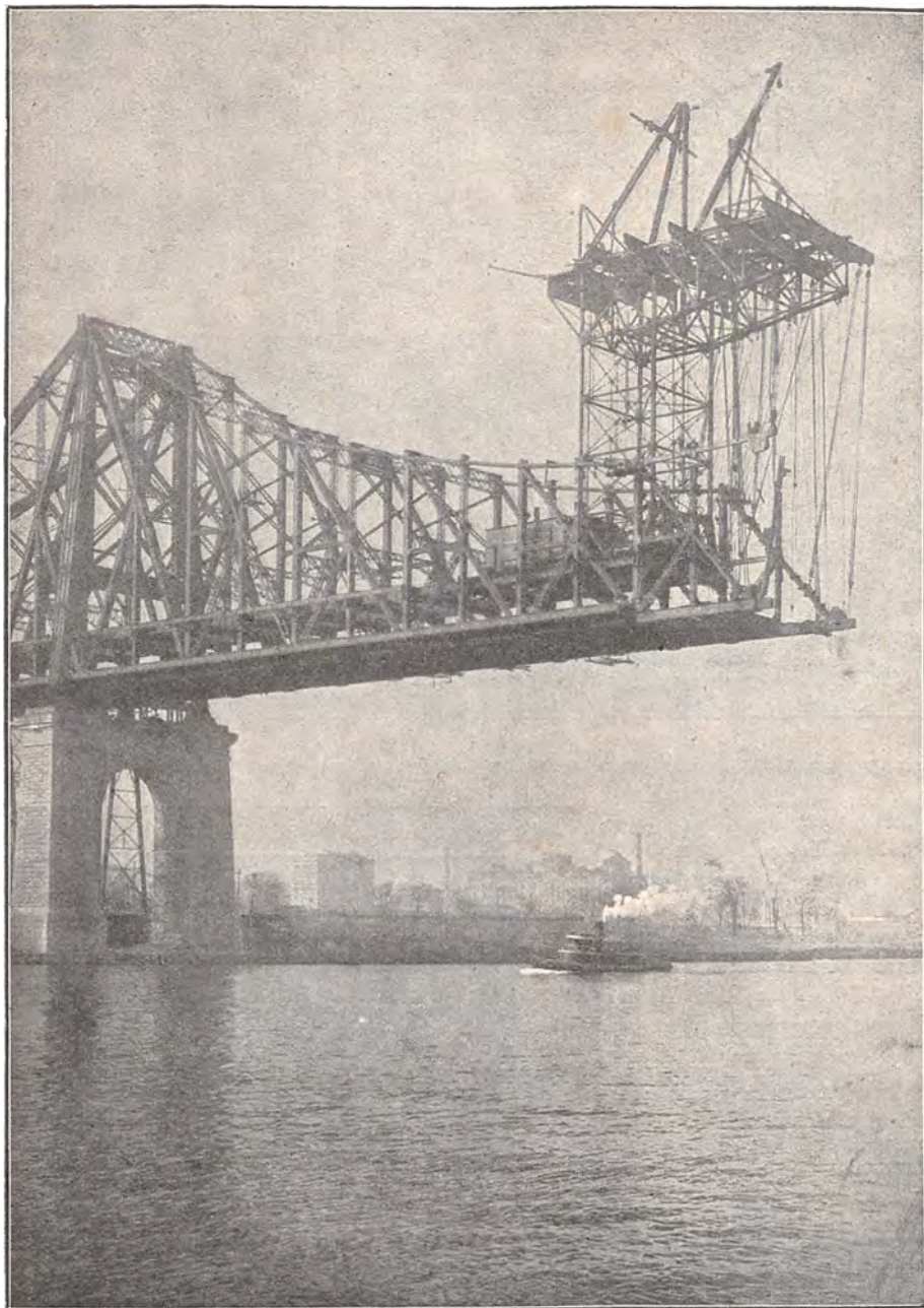
En tre Kilometer lang Bro bygges uden noget Stillads eller anden Understøttelse.
