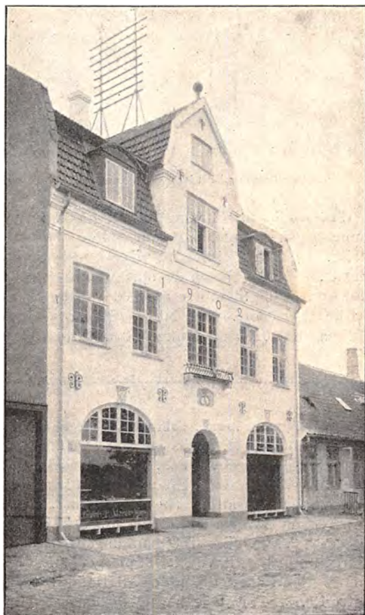
Arkitekt Warming: Bager Mørck's Ejendom i Hørsholm.
