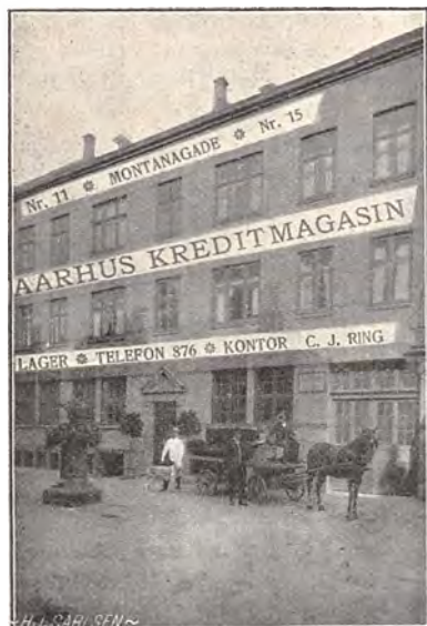
Aarhus Kreditmagasin, Montanagade 15.
