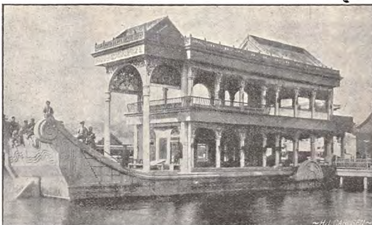
Enkekejsersindens Marmorskib. I Peking-Paladsets Sommerhave har Kejsersinden ladet bygge et Havehus i Form af et kinesisk Skib.
