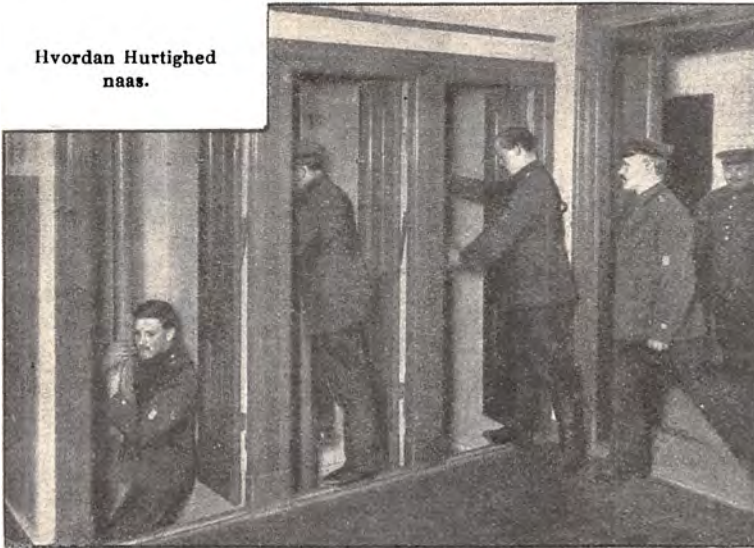
En ny praktisk Indretning i det Schönebergske Brandvæsen. Naar Alarmklokken lyder, styrter Brandmandskabet til Rutschestængerne, og
