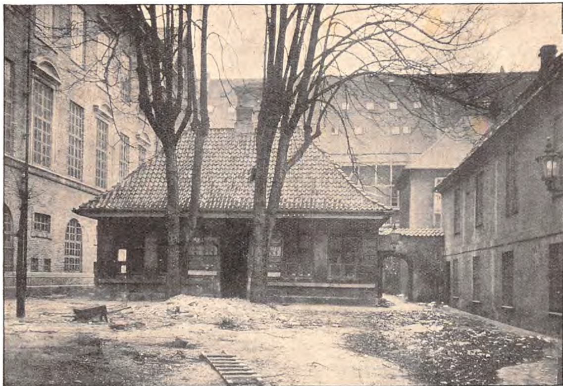
Den gamle Tøjhusvagt paa Slotsholmen. — Denne kønne gamle Bygning vil i en nær Fremtid blive nedrevet.
