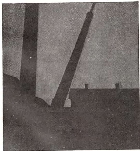
Den omstyrtede Skorsten paa Lervarefabriken Grøndal.
