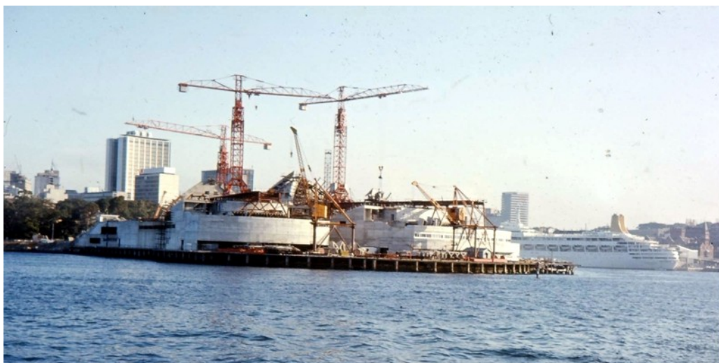
Byggeriet af Oprahuset Sydney 1964.
