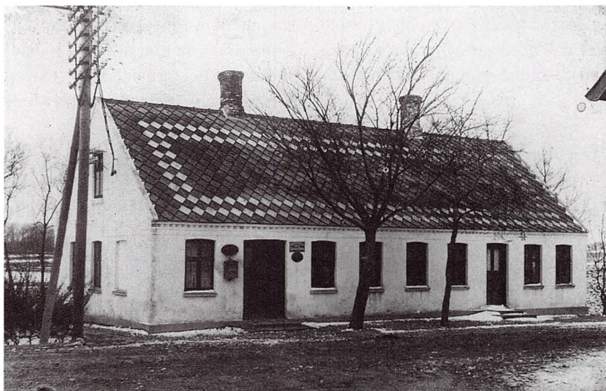
Under de fine mønsterlagte cementtagsten havde Christiane og Cort Jacobsen til huse. De bestyrede postsamlingssted og telefoncentral i Sdr. Dråby, o. 1950.
