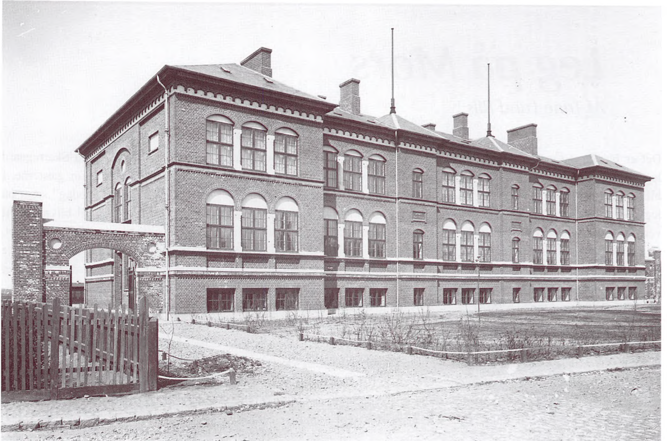
Man kan godt genkende stilen. Også M. C. Holms skole, den ny borgerskole, er tegnet af Momme og Olesen. Synes man den ser mærkelig lav ud er det korrekt – bygningen blev forhøjet med en etage i 1940-41, da Gymnasiet blev oprettet og rykkede ind her.
