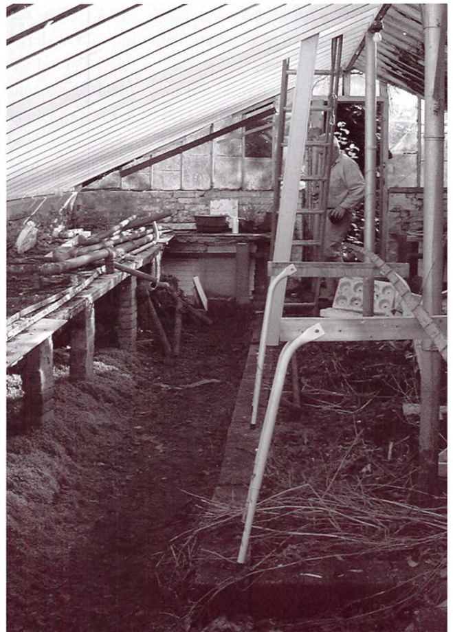
I dag bygges glashusene i aluminium og plast. Her istandsættes imidlertid et gammelt drivhus – så hertil behøves foruden muret væg, træ, glas, maling og kit. Huset er 11 meter langt og 5,5 meter bredt. Hertil går foruden vandplanker (rem- og fodstykker), 32 sprosser og 256 stykker glas – pr. side.
