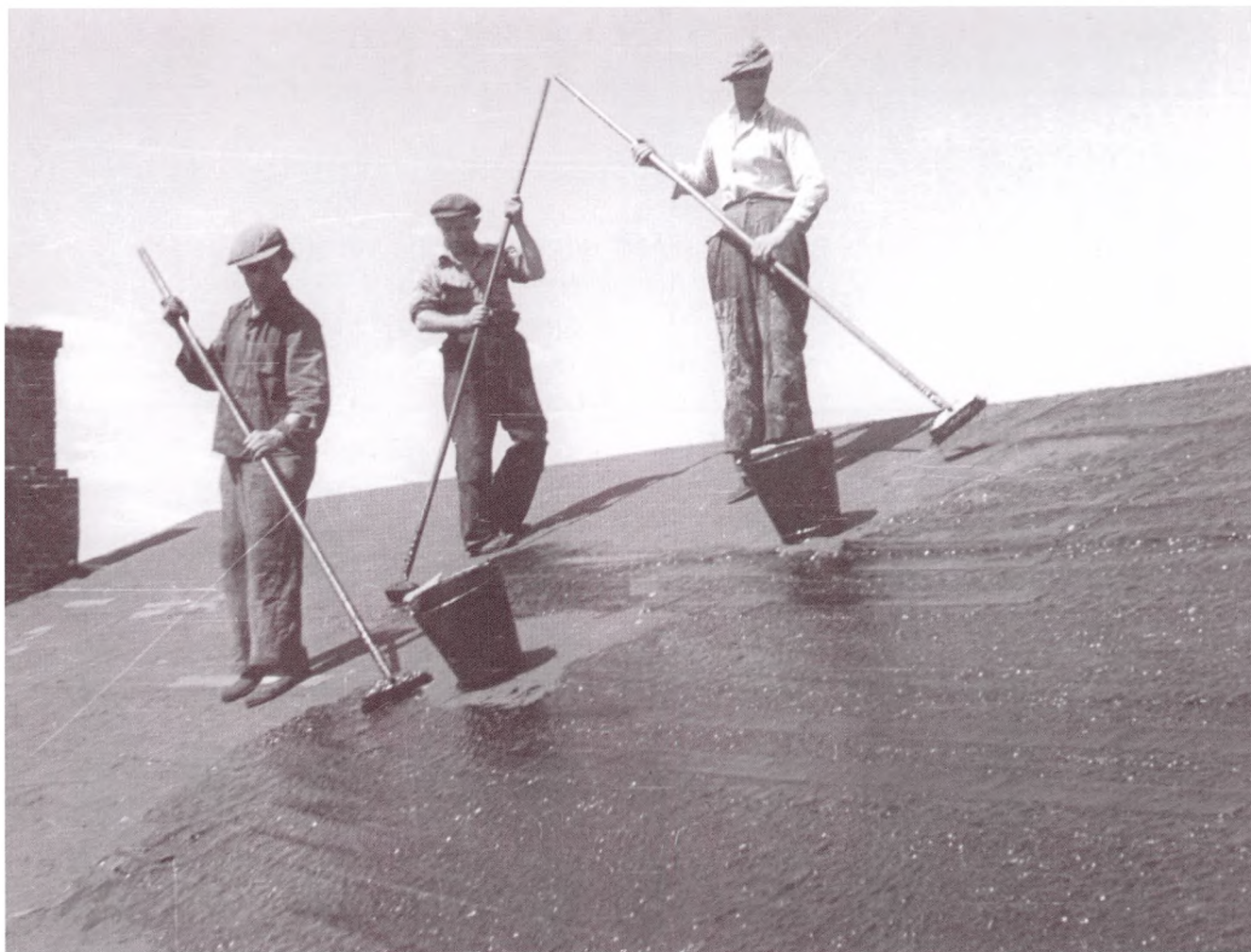
Bygningsvedligehold. Tag tjæres på Jernstøberiet, ca. 1948.
