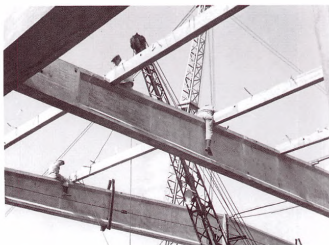
Den ny støbehal opføres i 195x. Byggeriet var det første af sin art i denne del af landet. De store bjælker blev leveret af Jydsk Betonelementfabrik ved Kolding, entreprenør var firmaet Ejner Mikkelsen A/S, Aarhus.
