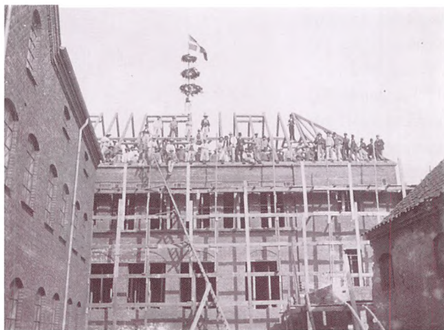
Rejsegilde på Jernstøberiets ny kontorbygning. Set fra gårdsiden, 1913.
