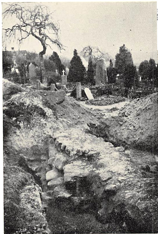
Fundament til den store Bygning ved Kirkebakkens søndre Fod.
