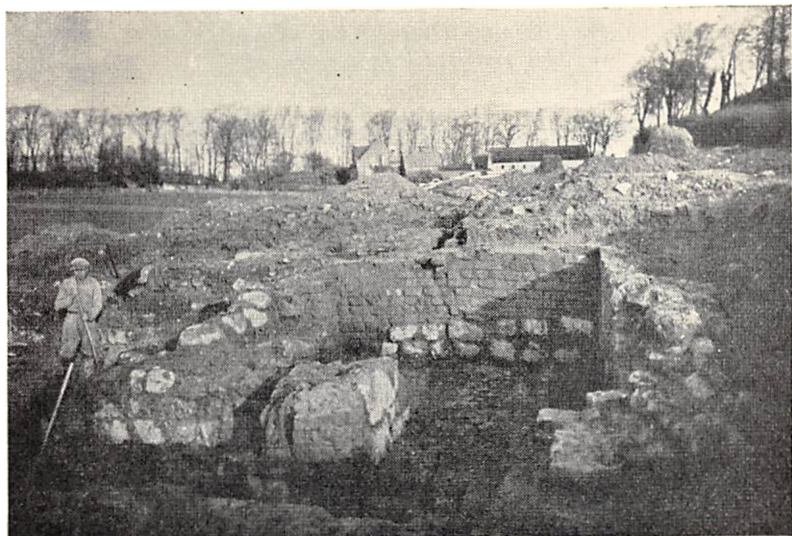
Bageste Del af indbygget Ovn set fra Nord.
