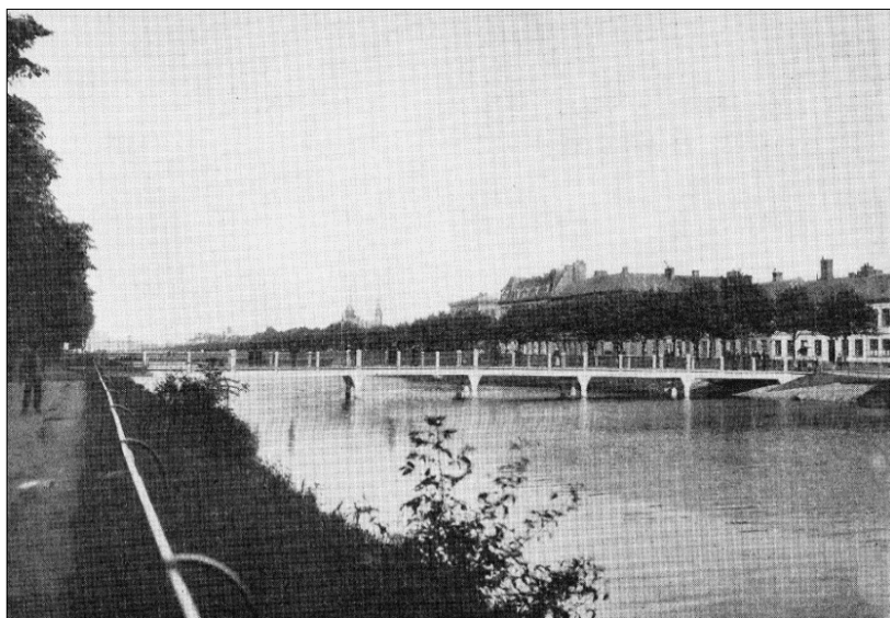
Bro i Kapitänsgaton bygget år 1909 af Cementgjuteriet
