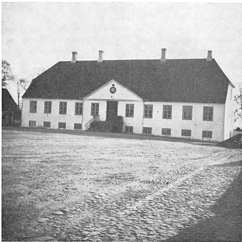
Falkenstein. Hovedbygningen er opført af munkesten fra Antvorskov klosterkirke. At hovedbygningen ikke fik lov at stå i de røde teglsten skyldes ny-klassicismens krav om hvidpudsede mure.
