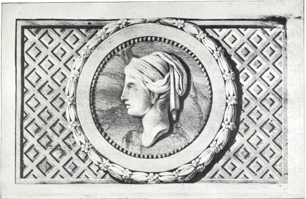
Fig. 1. Dørstykke fra Prinsens Palæ's Forbygning, opsat 1777.
