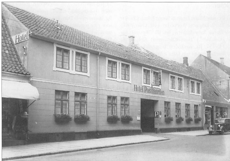
Fig. 4. Læserne skal nu ikke snydes for et billede af Hotel Postgården, så her bringes et ældre foto fra ca. 1940, som viser bygningens udseende, som det var fra ca. 1900 og til 1950'erne. Det var fortsat som på Dahls tid i bindingsværk, men 1. sals kvisten var i 1854 blevet forlænget hen til husets nordgavl, og kort efter år 1900 var bindingsværket blevet overpudset. Fot. fra Lokalhistorisk Arkiv for Sorø og Omegn.
