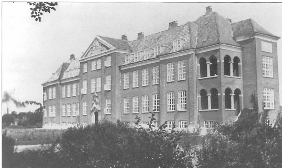
Den medicinsk-kirurgiske sygehusbygning, der blev taget i brug d. 1. juli 1920, og som den så ud, indtil den i 1939 fik bygget en ny medicinsk afdeling til i vestenden (t.v. på billedet), og en behandlingsbygning blev klistret på østenden i 1950'erne, hvorved det fine loggia-parti blev ofret. Bygningen er tegnet af de lokale arkitekter Knud Larsen og C. Andersen. Den rygende skorsten hører til Slagelse Bryghus. Foto fra ca. 1925.
