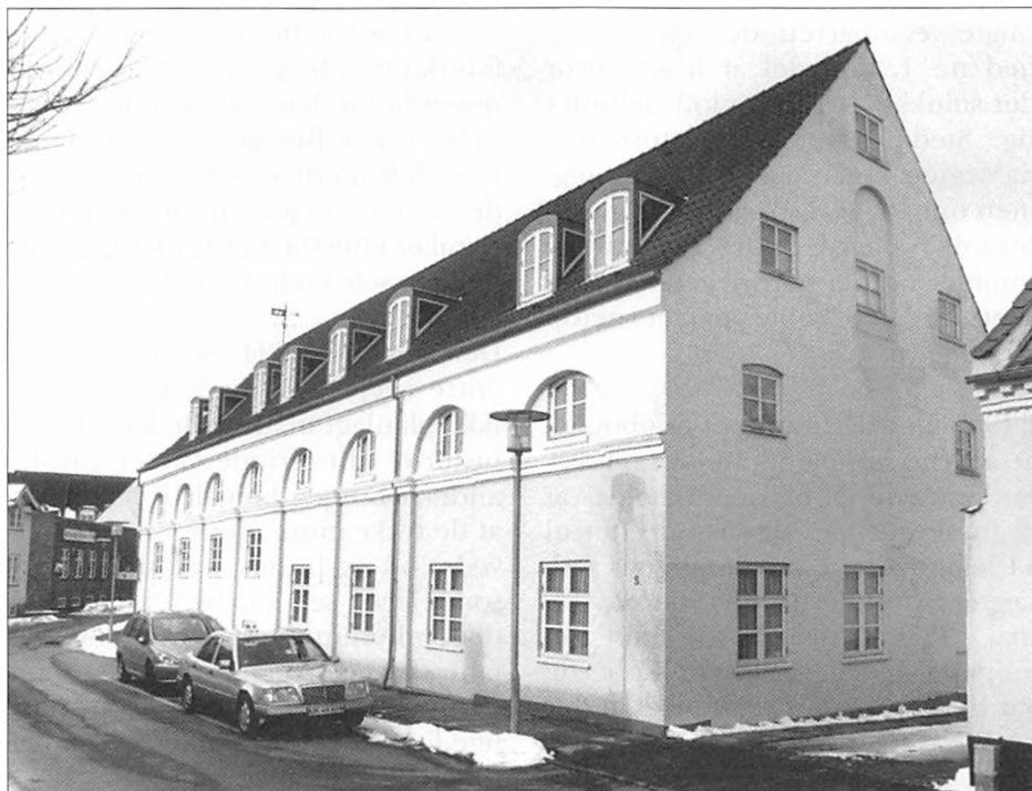
Illustration 14: Familien Kierulffs bryggeribygning i Hestemøllestræde 5, som den ser ud efter at være blevet restaureret og indrettet til ejerlejligheder i 1987. Huset fik ved den lejlighed navnet Bryggergården. Foto: Tage Ludvigsen.
