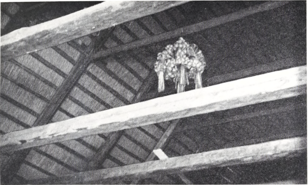
Fig. 51. Krans af hovlspåner hængende i hanebåndet, Romo 1951. Kranen stammer fra rejsegildet året før; det er den, der ses længst til højre på fig. 47.
