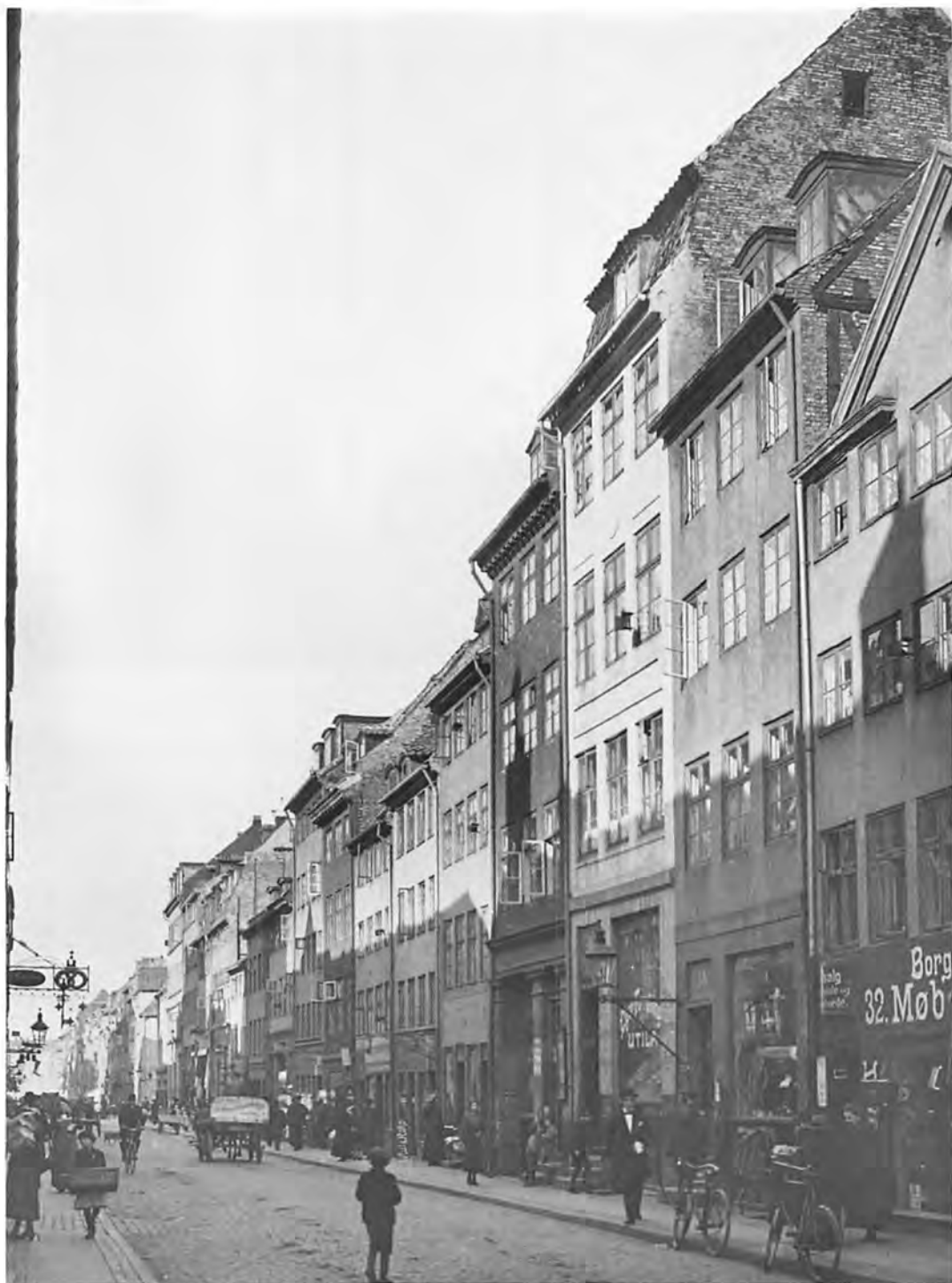
Borgergade med nr. 32 til højre og nr. 60 i billedets anden side. Det afsnit af gaden understreger gadens udvikling fra lav »rækkehusbebyggelse«, men tilbygget og forhøjet til helt forregnede, små skyskraber på fire etagers højde. Udenomsbekvemmelighederne kunne i det lange løb ikke tilfredsstillende det stadig øgede beboerantal. 30-40 beboere pr. hus var ikke usædvanligt allerede i forrige århundredes slutning. Fot. 1915. – Bymuseet.
