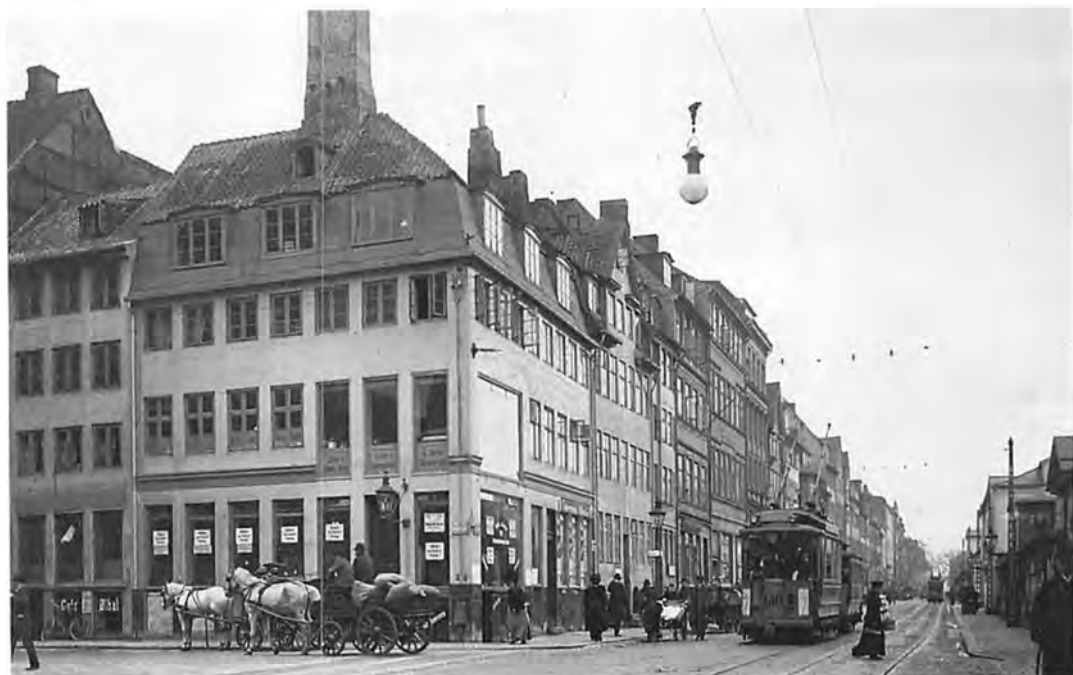
Typiske bygninger i Gothersgade 73-81 på strækningen mellem Møntergade og Landemærket, der faldt omkring 1906 for at skaffe plads til Møntergården, Belysningsvæsnet og Gutenberghus (se bind 4). – Fot. 1909. Bymuseet.
