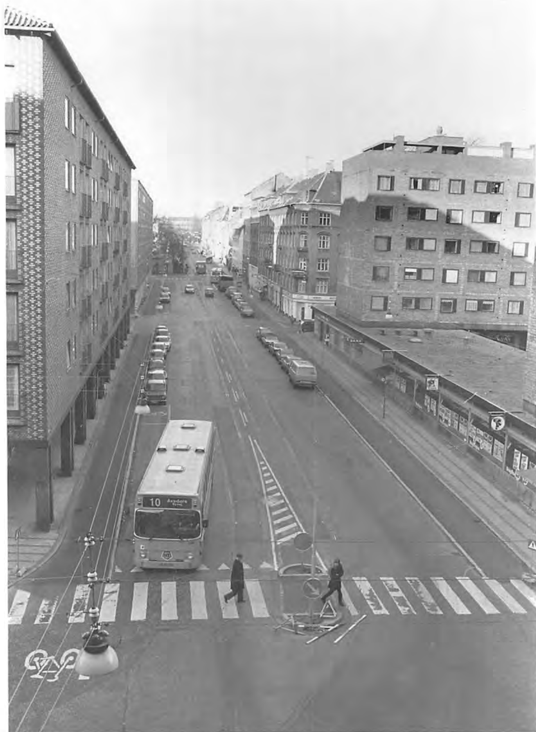
Her er den forlængede Sølvgade set fra Borgergade med Sølvtorvet længst tilbage i billedet. Det er »forlængelsen«, man ser i forgrunden med Sølvgadehus mellem Borgergade og Adelgade til venstre og med den opgivne og nu bebyggede Christian 10.s Plads til højre. – Fot. 1978. Nordfoto.
