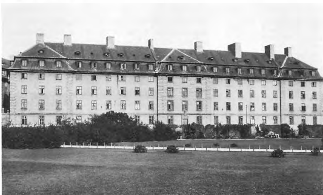
Sølgades Kaserne, som siden 1927 har huset DSBs administration, er en fornem bygning, opført af N.-H. Jardin under ledelse af kaptajn C. C. Pflueg i 1765-71 som den første statsejede kaserne i København for det dengang hvervede danske og norske livregiment. Den bestod oprindeligt af to lige store sidefløje, som først i 1853-55 blev forbundet med en tilbygget fløj mod gården. Her er højre fløj på 21 fag set fra taget af Herkulespavillonen. – Fot. Hans Jørgen Ørslev 1986.
