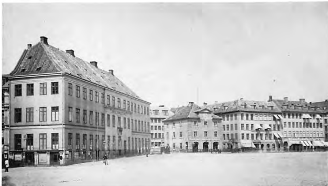
Der er ca. 85 år mellem dette billede og billedet nedenunder. Her ses Hotel d'Angleterres naboer mod nord, Hovedvagten og forretningskvarteret ved Gothersgade-hjørnet. Det er de bygninger, der er omtalt på de følgende sider. Fot. 1865. – Bymuseet.
