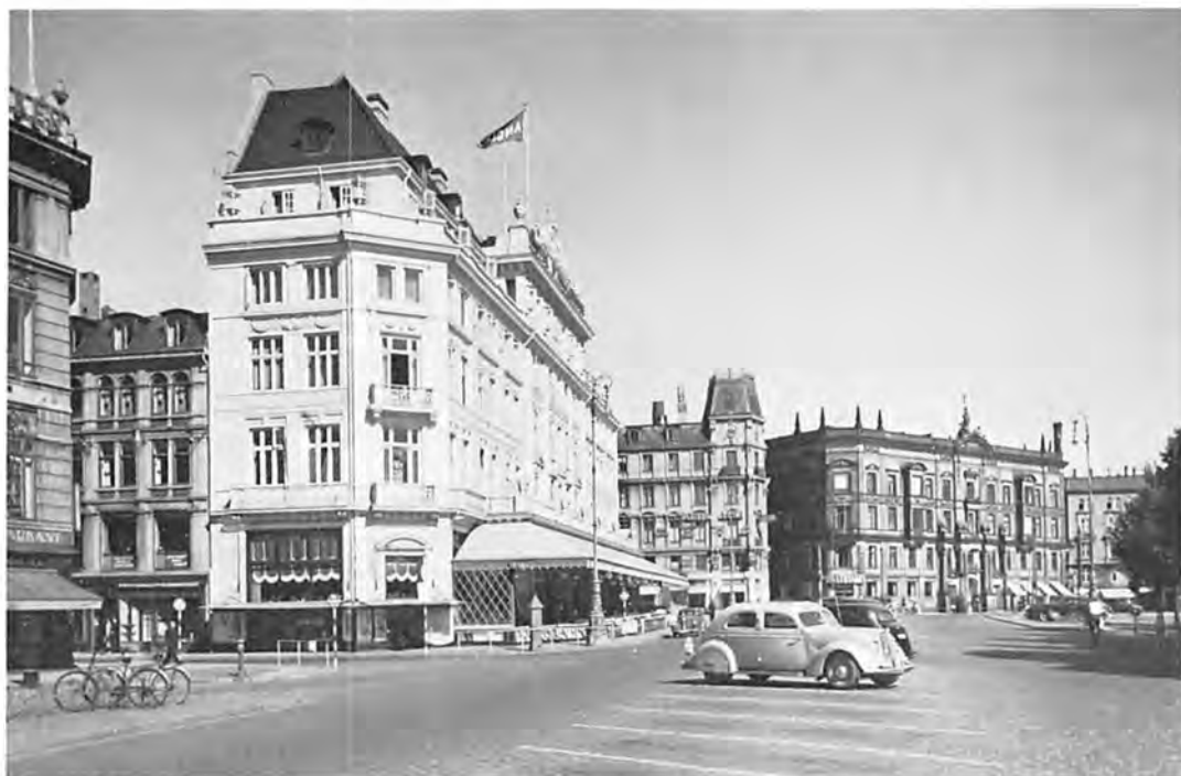
Samme motiv som ovenfor 85 år senere. Hotel d'Angleterre er yderligere forhøjet én etage og pudset op af Nicolai Hansen og Philip Smidth efter en alvorlig brand 5. marts 1915, der navnlig raserede sidefløjen langs Hovedvagtsgade. 200 gæster måtte evakueres i nattens løb. Naboerne er nu Strygejernsbygningen fra den nye Hovedvagtsgade fra 1873 og Blichfeldts bygning for Store Nordiske Telegraf-Selskab. – Fot. ca. 1950. Bymuseet.
