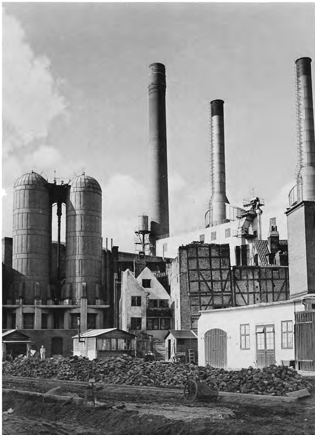
Elektricitetsværket fra 1892 ved hjørnet af Gothersgade og Borgergade. Det havde oprindeligt været gemt bag randbebyggelsen, men trængte nu stærkt til udvidelse og beslaglagde i saneringsplanen en hel, stor karré, hvori Helsingørgade næsten forsvandt, idet kun en lille del er bevaret som indkørsel til værket. – Fot. 1942. Bymuseet.
