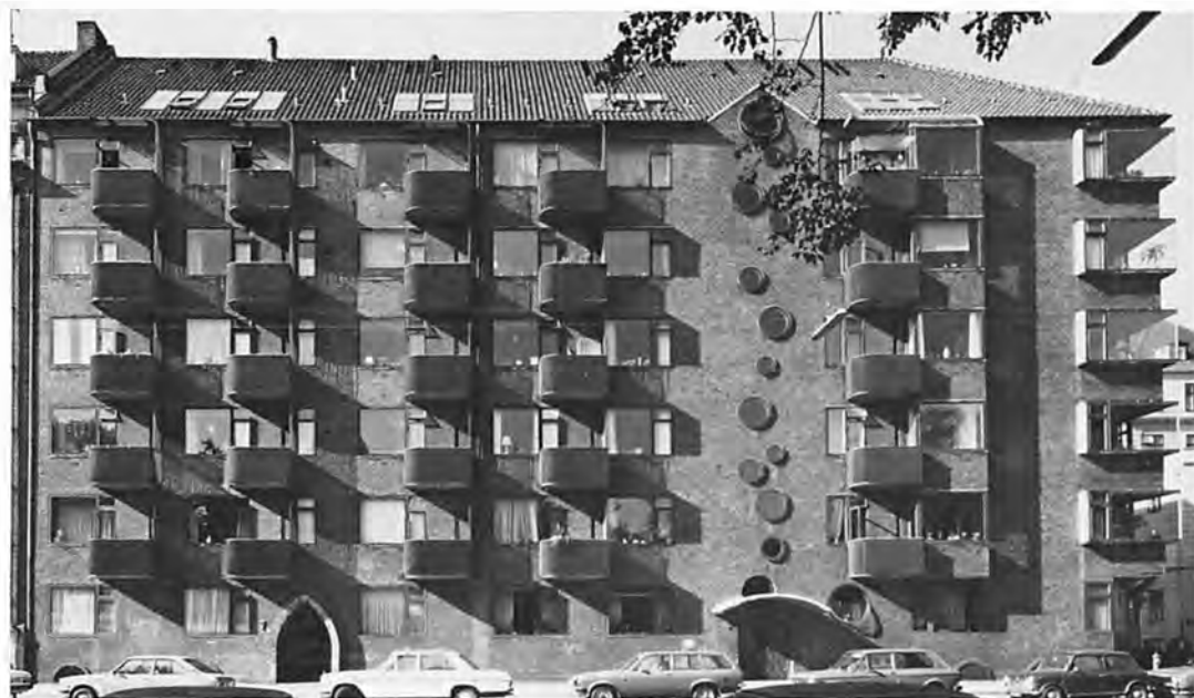
Grønningen 7-9 og Hammerensgade 8 blev et af de sidste huse, der opførtes sidst i 1930'erne i Grønningens 25 år lange tilblivelsesperiode. Det var bygget i 6 etager med store lejligheder. Bygherren var A/S Daros og arkitekten Ib Lunding. Fot. 1976. – Kunstakademiets Bibliotek.
