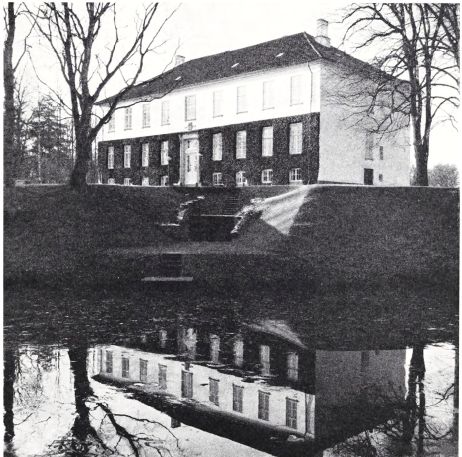
Hovedbygningen set fra øst. I forgrunden voldgraven. Midt i billedet ses den frilagte og restaurerede ruin af det middelalderlige porttårn.
