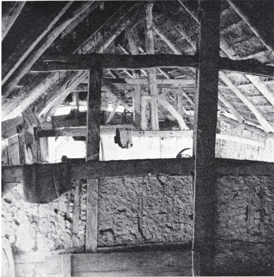
Fig. 12. Samme ejendom på Helnæs. Ladens tag bæres af suler midt hen gennem bygningen. I forgrunden de lerklinede tavler af en tværvæg, hvis tømmer stiver ydervæggene af mod tagets tryk. P.M. fot. 1960.
