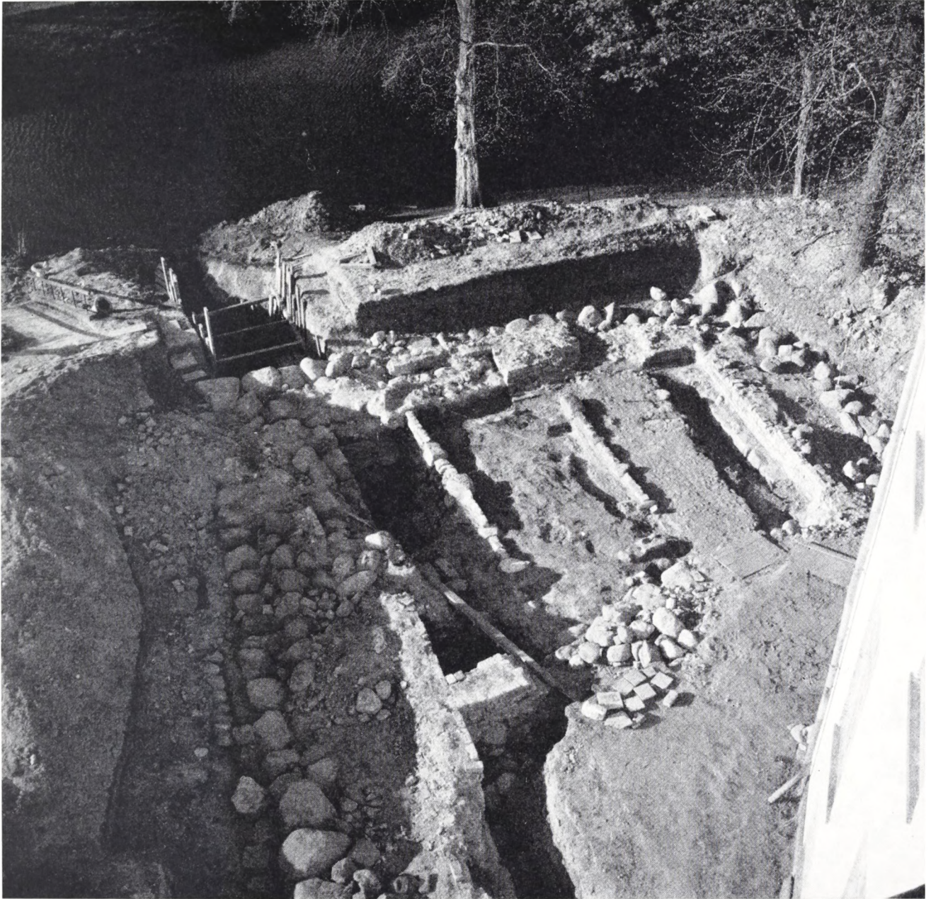
Det store, gotiske hus under udgravning. Set mod nord fra hovedbygningens tag. De to tynde, nord-syd gående skillerum er ikke oprindelige. Ved husets nord-vest hjørne ses det nordre hovedsnit. Øverst i billedet voldgraven.
