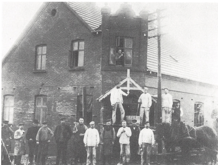
Hundborg Apotek under opførelse.
