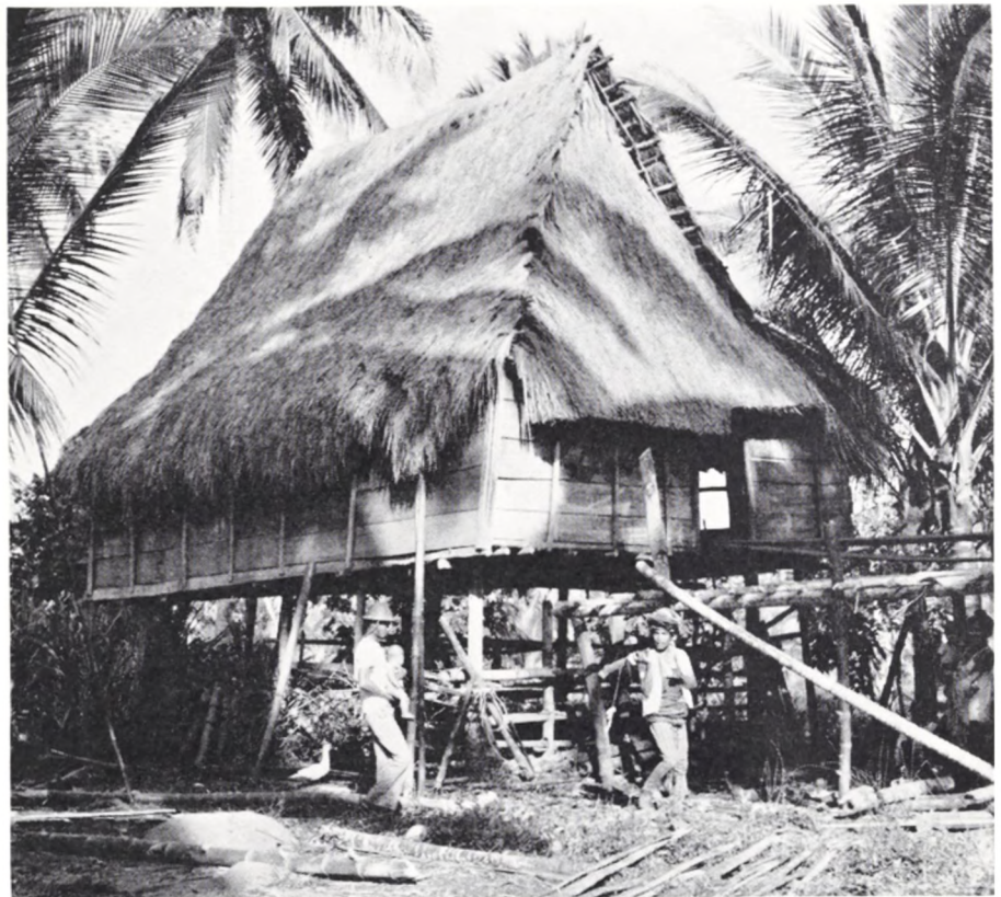
Fig. 6. Yakanhus. Væggene er enten, som her, bygget af planker, eller de er flettet af udbankede spanskror; taget er af græs eller palmeblade. Manden til højre i typisk yakanragt: benklæder af sribet, hjemmevævet stof, hvid trøje og et 15 m langt rødt bælte. Han er en af de få yakanmænd, som endnu har langt hår, vundet om hovedklædet.
