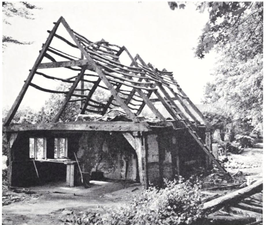
Fig. 5. De ældste fem fag af huset efter nedtagning af de øvrige fag. Ved enderne har været fremspringende, knægtbårne gavle. Frode Kirk fot. 1962.
