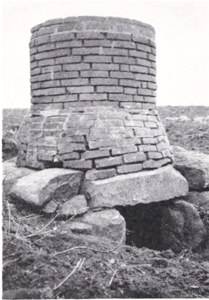
Fig. 2. Høroven fra „Kattekær“ før nedbrydningen ved overføring til Frilandsmuseet.
