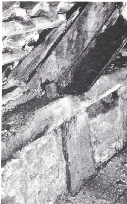
Fig. 13. Detail af styrterumskonstruktion i Nørregade 31 i Køge.
