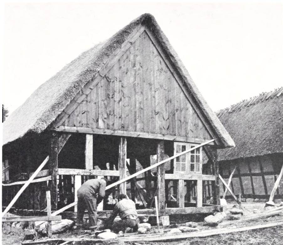
Fig. 4. Huset under genopførelse på Frilandsmuseet. Stensylden lægges under sydgavlen, der genskabes, som den så ud før en sen ombygning. P. M. fot. 1965.
