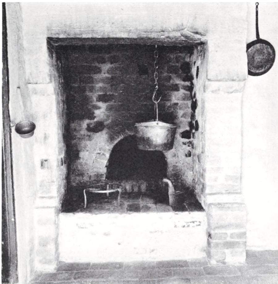
Fig. 13. Den åbne skorsten i køkkenet med munding af bagerovn og muret ildstedbænk. Gryden hænger i en kæde fra en jernstang på tværs af skorstenen. N. Elswing fot. 1967.
