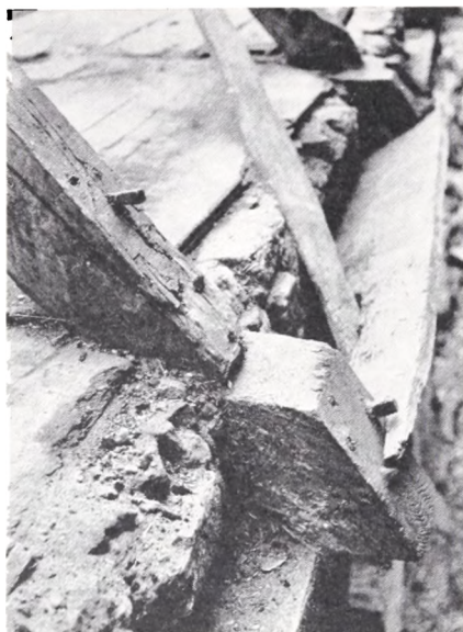
Fig. 6. Detalje fra nedtagningen af huset. Tækkemateriale og lægter er fjernet. Man ser spærfoed og bjælkeende, endvidere en stormlægte og det bræt, der har lukket tagskægsåbningen. Frode Kirk fot. 1962.
