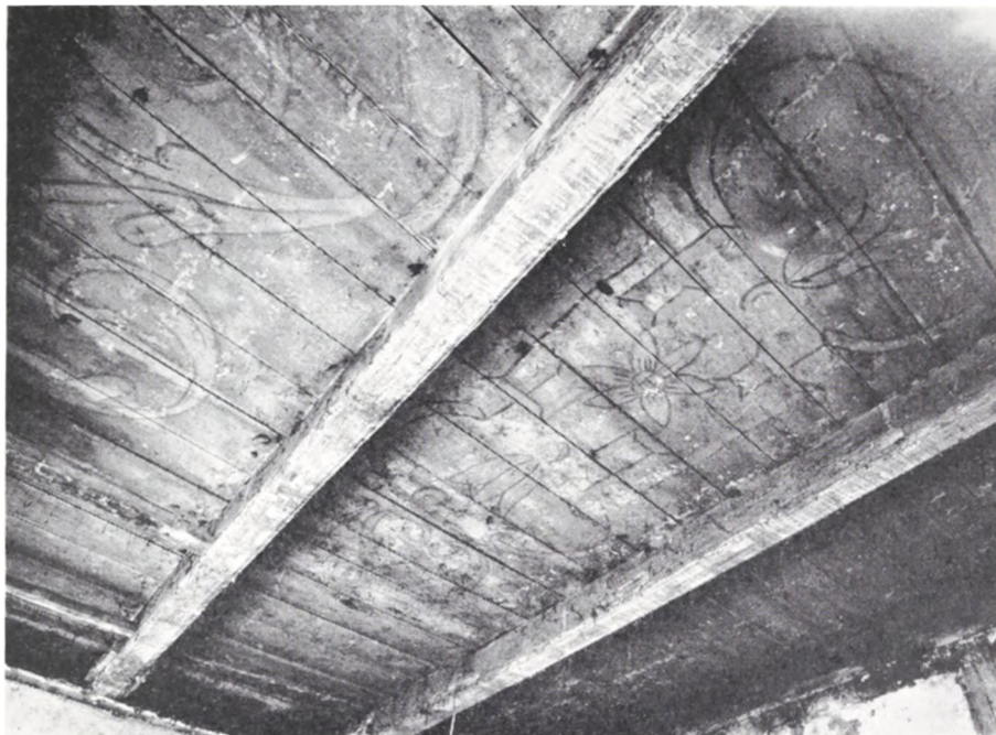
Fig. 8. Dekoreret loft fra Åbenrå 1 efter at gipsloftet er fjernet.
