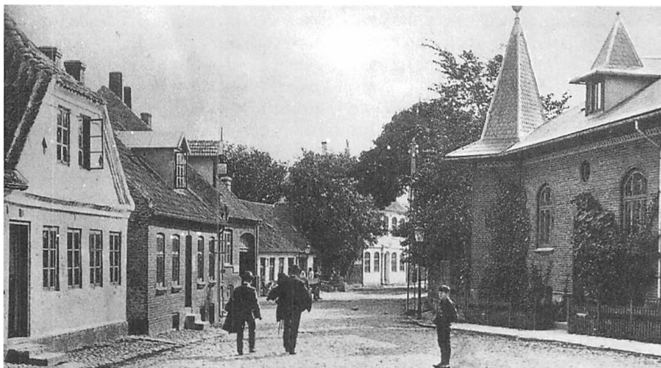
Det forsvundne Grydetorv med Thisted Amtsavis' redaktorbolig til højre.
