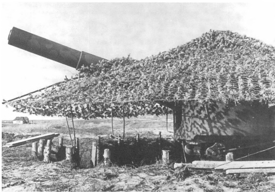
Tysk 17 cm kanon i batteriet i vildtreservatet neden for Hanstholm. Billedet er taget i august 1943, næppe meget har dog ændret sig ved kanonstillingen siden foråret 1940. Det var først i foråret 1944, de store kanonbunkere blev bygget. (Frihedsmuseet).
