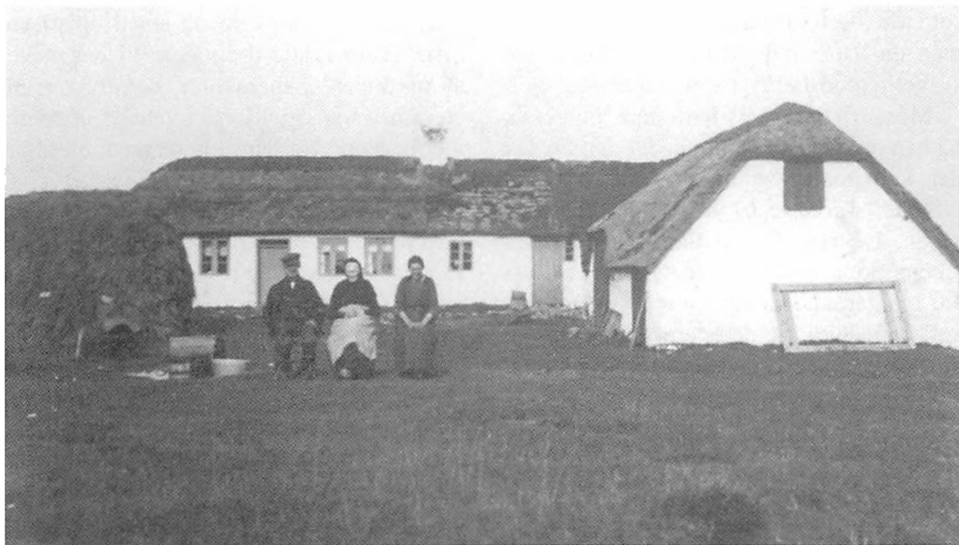
Peter Dybdahls gamle hus, som blev nedrevet ca. 1920, da Carl Dybdahl havde købt en ejendom ovenfor på bakken. Der byggede han nyt stuehus 1920, og siden byggede han om på udhusene.
