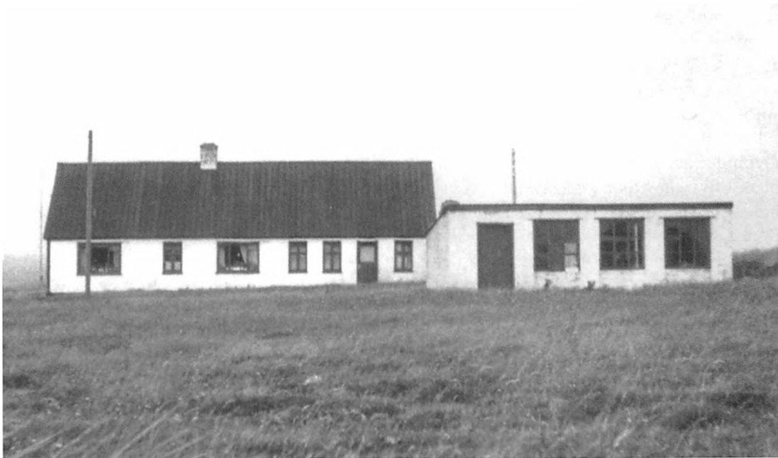
Mine bedsteforældres hus på Baunvej. Huset er nu ombygget.
