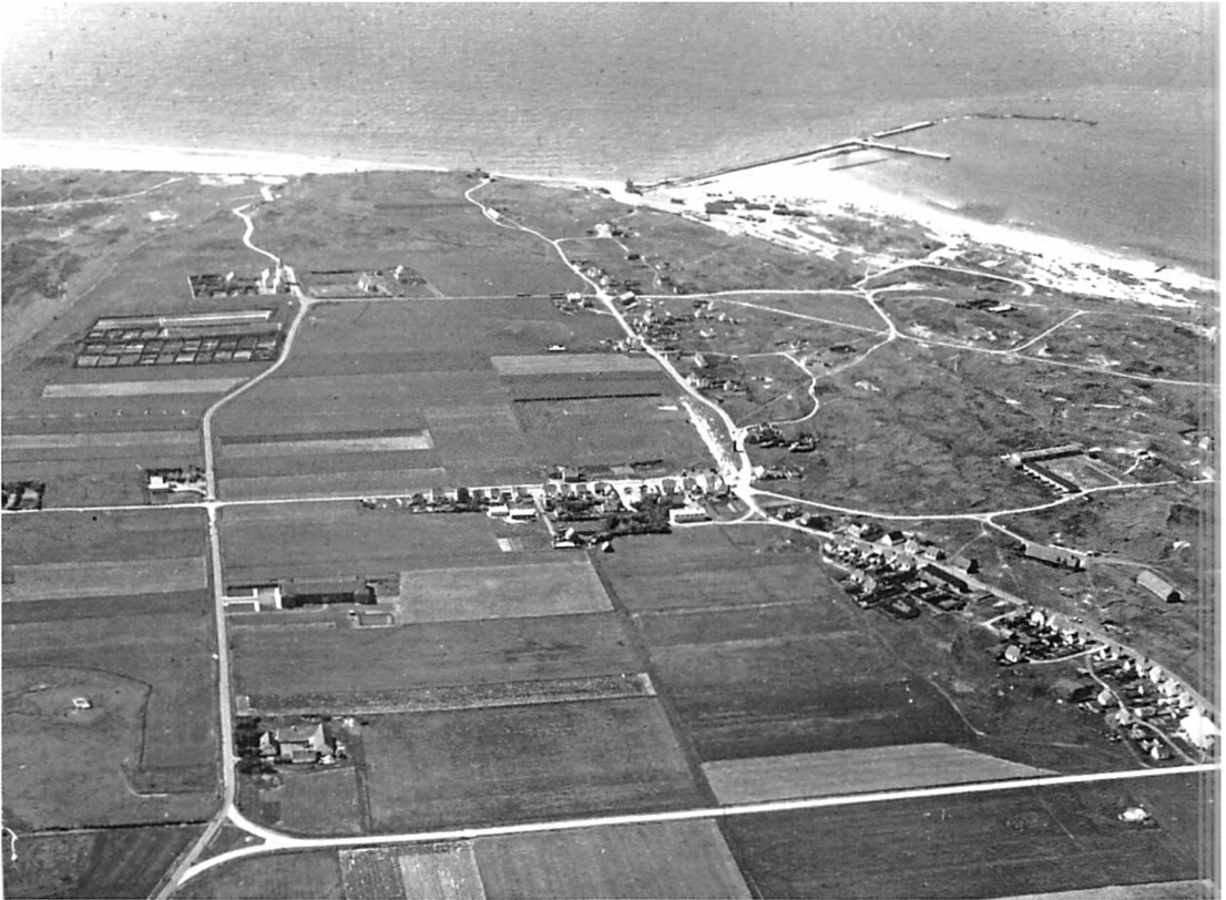
Så langt nåede havnebyggeriet før Anden Verdenskrig: 1 km vestmole og et stykke af tværmolen. Bemærk de enorme sandaflejringer i læ af vestmolen. Samtidig bortskar voldsomme storme 80 meter af kystlinjen mellem Helshage og Roshage. Det skabte betydelige vanskeligheder for kystfiskerne.
