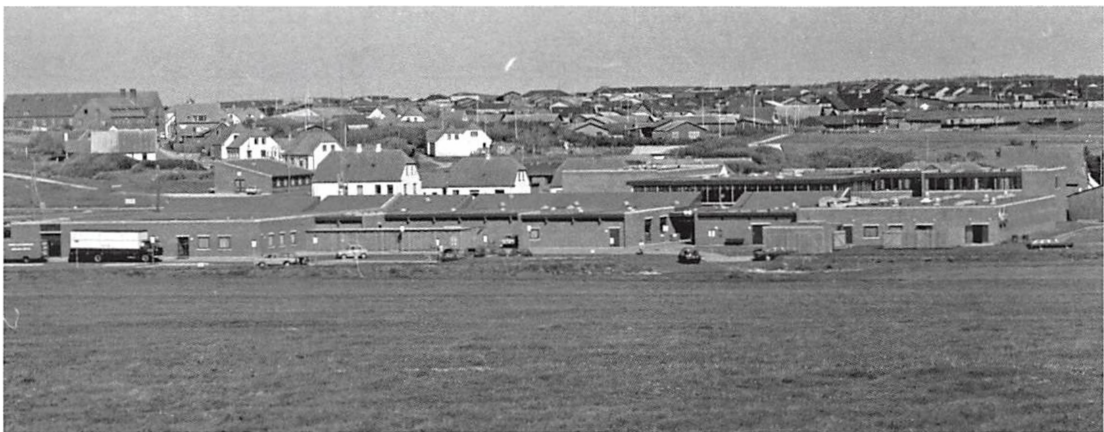
Dødsdommen over de hvide huse blev heldigvis ikke eksekveret. I få byer træder de historiske lag så tydeligt frem som i Hanstholm. I forgrunden af dette billede fra 1970'erne ses det nybyggede center. Bag centret ses de hvide huse, bygget under det første havnebyggeri i mellemkrigstiden. I baggrunden den funktionelle villaby, der er mere i slægt med Munkebo og Albertslund end med byggetraditioner i Thy.
