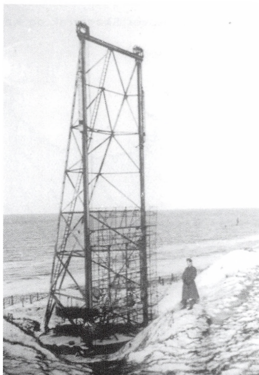
Fig. 1. Radar af typen »Fahrstuhl-Freya« fotograferet ved Nørre Lyngby nord for Løkken i 1945. (MuseumsCenter Hanstholm).
