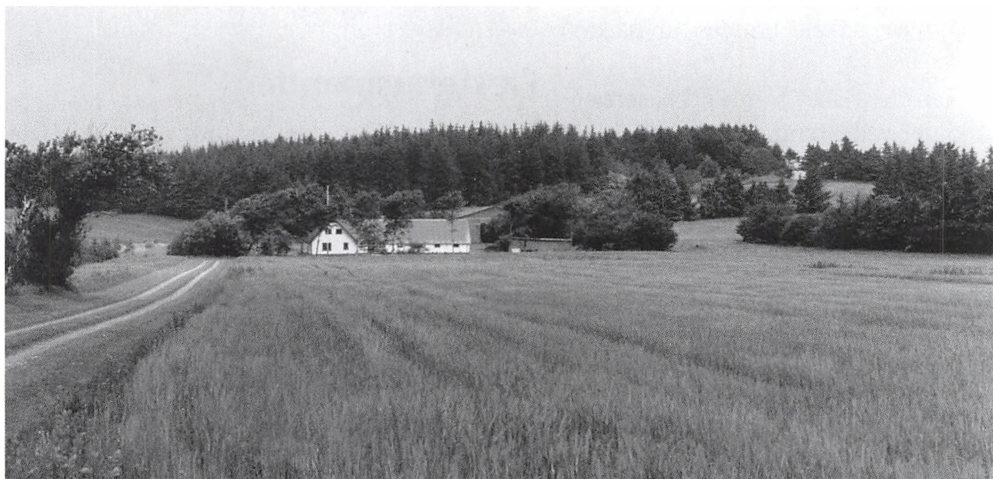
Fig. 1. Niels Jensen Skrædders husmandssted i »moderne forklædning« (fra 1910) set fra Hindingvej. Placeringen som den ses her – lidt til højre for vejen – er den samme som i 1787 (se fig. 3 og 4) og sikkert også den samme som det hus og den kålhøve, som Niels Jensen Skrædder havde. (Foto: Bjarne Gade Johansen, 2002).
