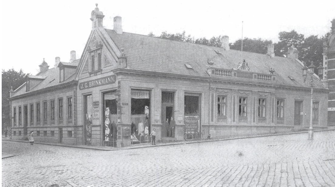
Familien flyttede fra Dr. Louisegade til Store Torv – til en lejlighed i købmand (manufakturhandler) J.G. Brinkmanns ejendom. Fra bagsiden var der åbent til kirkegården omkring kirken. Billedet er fra 1910. Ejendommen blev revet ned i 1930'erne i forbindelse med omlægning af torvet. Bilismen krævede parkeringsplads.
