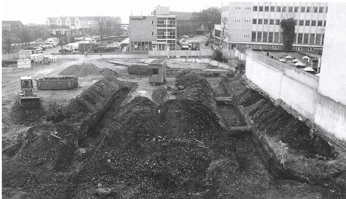
Fra tandlægeklinikken på den anden side af Storegade var der et godt overblik over udgravningsområdet. Midt i billedet ses de to parallelle søgegrøfter.
