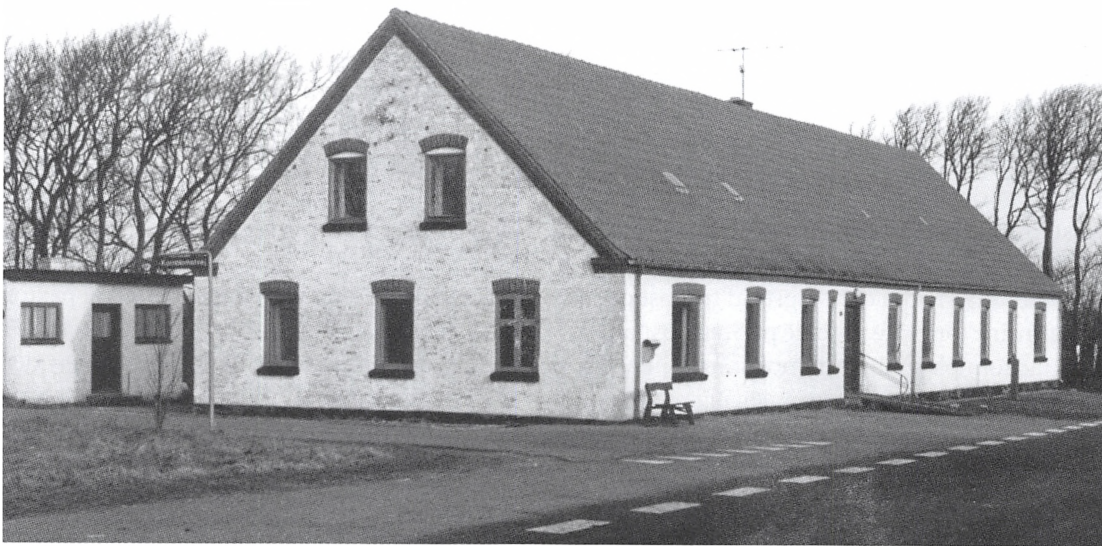
Hillerslev alderdomshjem, også kaldet »Asylet«. Foto: NSH.
