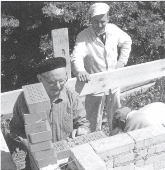
Far lægger mønter ved grundstenen. Murermester Hebsgaard kigger til. 1962.
