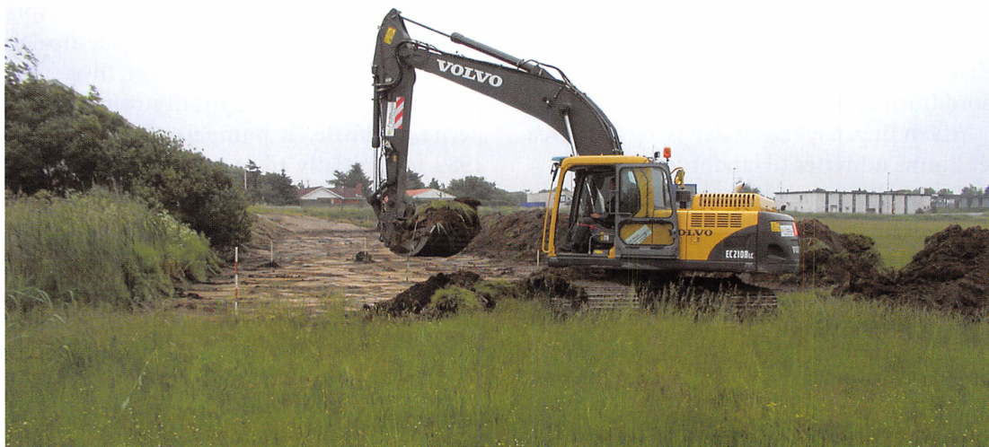
Første spadestik til diget ved Vildsund. Foto: Henrik Schjødt Kristensen.
