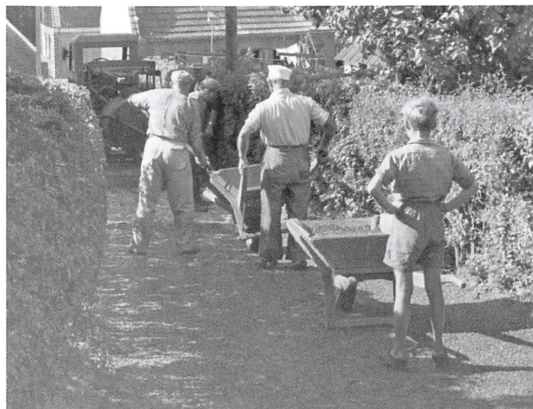
Bakkevej var først en grusvej. I 1957 blev den asfalteret.
