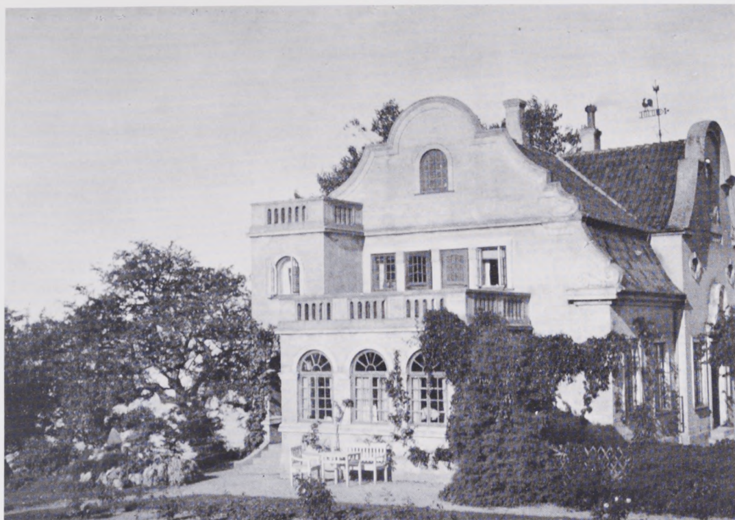
Fig. 15. Huset blev for lille til familien. De gamle bygninger blev nedrevet, og i 1910 var den ny „Strandhytte“ klar til indflytning.
