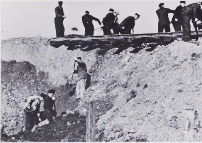
Fig. 13. Oprydningsarbejde på hovedlinien ved Holmstrup nær Odense i Frihedskæmpere og Englændere. Optagelser efter bombeangreb og sabotager giver ofte bedre end billeder af selve eksplosionen filmet på sikker afstand mulighed for at bedømme virkningen.
