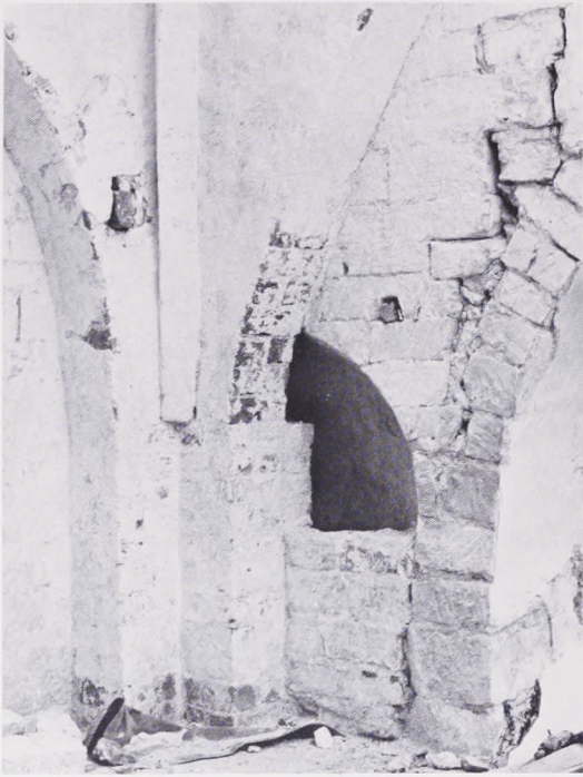
Fig. 7. Sidealterniche nord for korbuen delvis skjult af den senere hvælvpille. Kun den øverste halvdel af nichens tilmuring er fjernet. Den runde afslutning er hugget ud i murværket. Den søndre side er omsat som følge af korbuens udvidelse. Fot. 1976.
