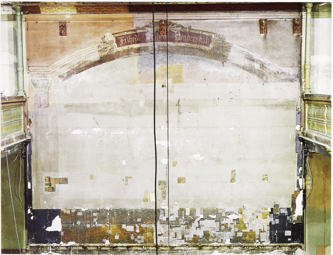
Fig. 6. Bagvæggen efter stabiliseringen af pudslaget og udbedring af de mange skader. Øverst på billedet ses den del af decorationen, som ikke var overmalet. Næste fase var afdækningen af maleriet »Et dansk landskab« fra 1907.
