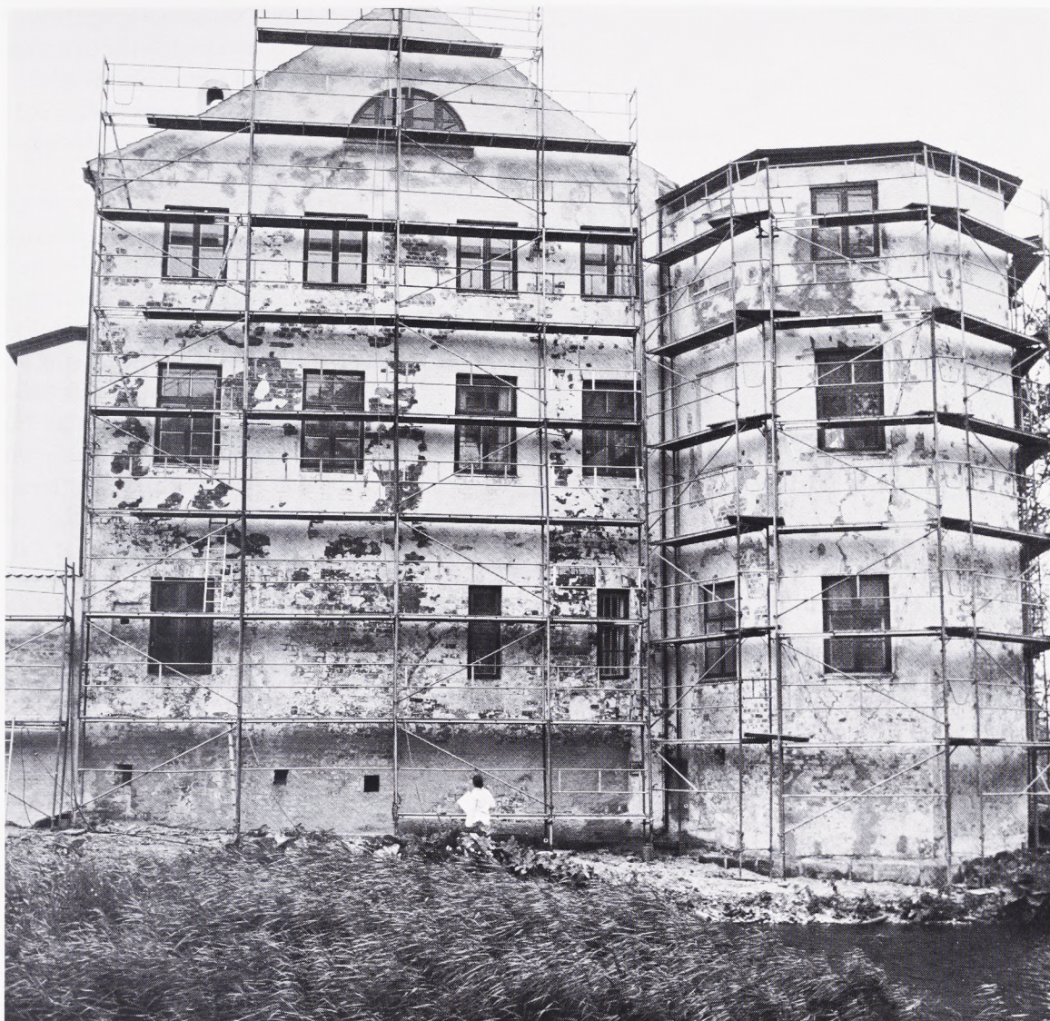
Fig. 3. Nordfacaden under restaurering 1984. Den hvidklædte skikkelse står neden for den tilmurede port, hvis top er gennembrudt af et yngre vindue. Forneden i midten et af broens fem bjælkehuller og, til venstre herfor, to skydeskår.
