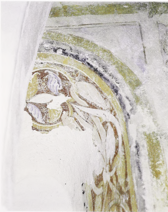
Fig. 15. Mårslet kirke, romansk vindue under afdækning. Bemærk det tykke, grove overkalkningslag.
