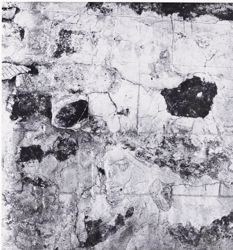
Fig. 6. Mårslet kirke. Udsnit af bygningsmørtelen. Udglatningen af vægfladen bevirker, at granitten flere steder træder frem i overfladen. De mange svindrevner i mørtelen er fremkommet på grund af det store indhold af kalk og ler sammenholdt med, at den er lagt på i et temmelig tykt lag. Forhugninger er lavet for at få en god forankring af malepudsen. Under den aflange lyse sten ses bomhullet, som er lukket med en sten, indmuret med mørtel svarende til malepudsen.
