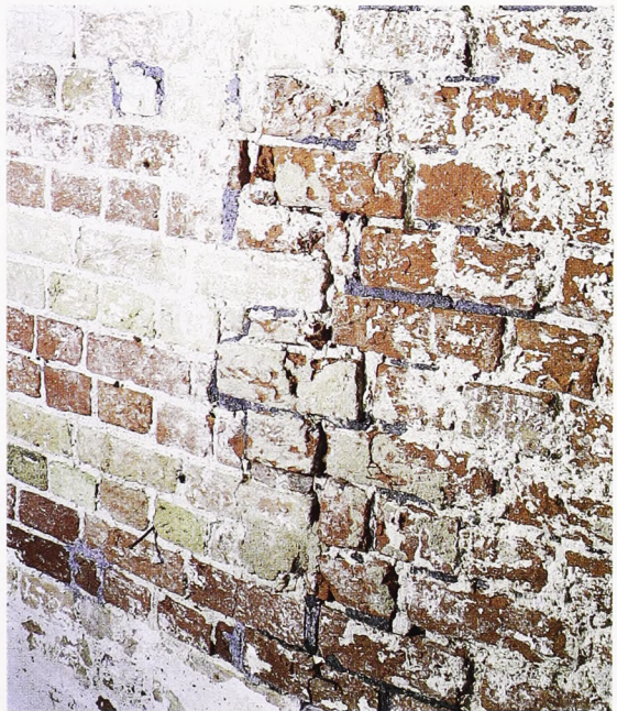
Fig. 11. Sammenføjnngen mellem vestfacadens bæltemurværk, ca. 1530, og murværk med sorte fuger, ca. 1550.
