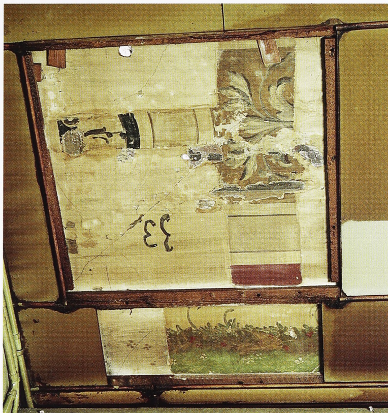
Fig. 1. Detalje af glasloftet. Under den fjernede glasplade ses de af-dækkede dekorationslag. Det ene af disse lag skimtes på fig. 2.
