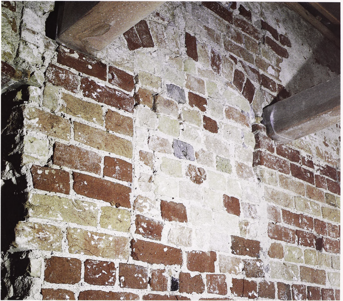
Fig. 10. Stueetagens oprindelige vestfacade med bælttemurværk og tilmuret vindue.
