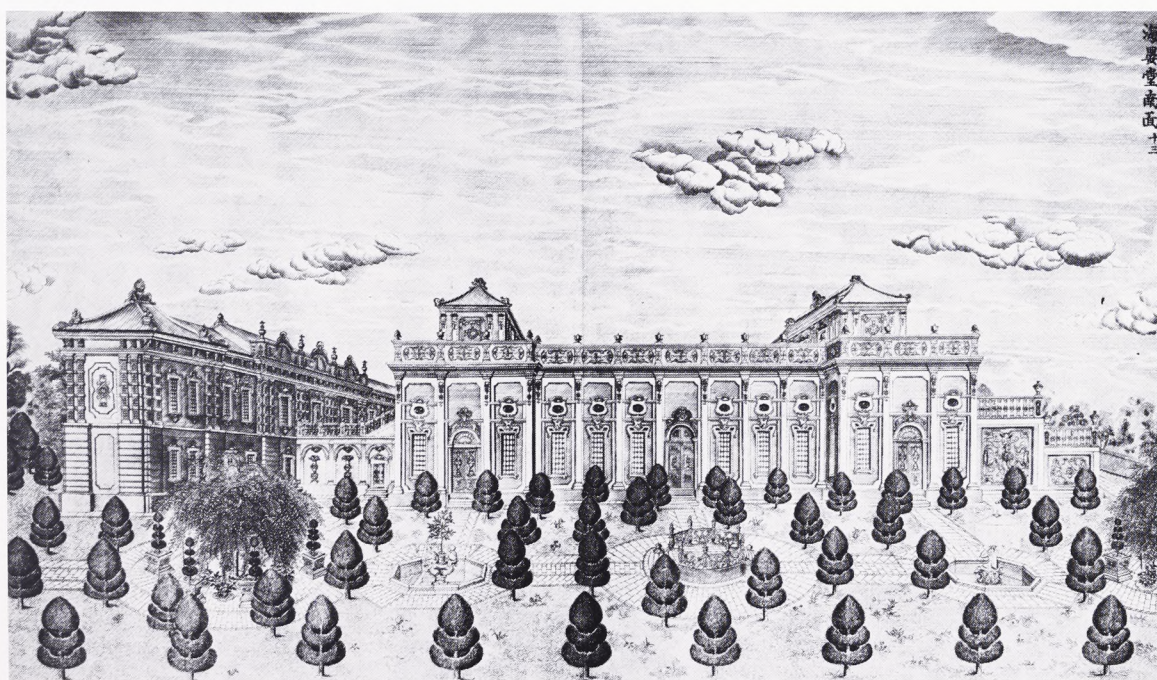
Figur 12. »De fredfyldte Haves Hal« set fra syd. Keiserens spejlgalleri lå på første sal i vestfløjen, medens resten af bygningen tjente som vandreservoir for anlæggets vest-østgående område. Bag de blandede døre og vinduer fandtes »Tinhavet« (et bassin, der var foret med tin og hvori man opdrættede fisk) anbragt mellem to pumpehuse. Podiet i forgrunden var et af de mange udsigtspunkter, hvorfra kejseren kunne nyde springvandene omkring de »europæiske paladser«.
