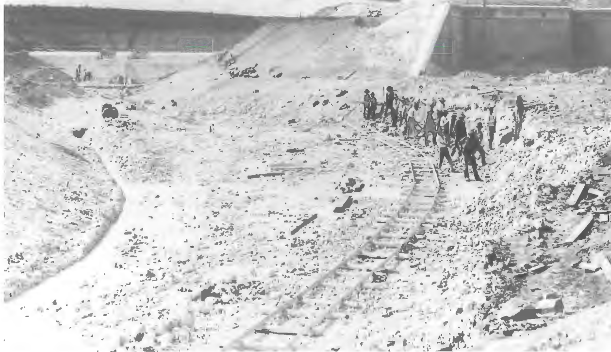
Arbejde i kalken ved Avedøre Tværvæg maj 1890. Foto: Historiens Hus Hvidovre
