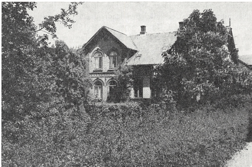
Haderslevvej 23, bygget 1896 af C. Iversen.
