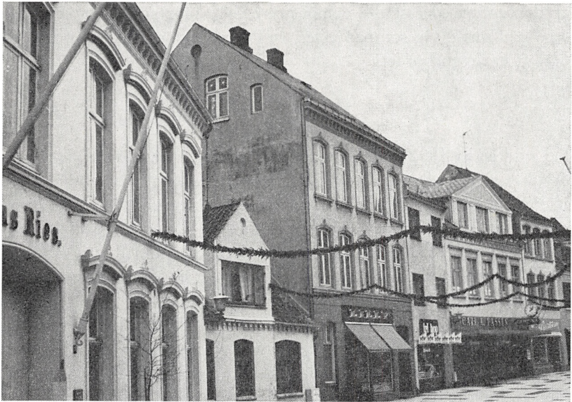
Nørreport set mod nord. Til venstre nr. 30, opført 1886 af Peter Callesen d. yngre for kornhandler Ries. Nr. 28 fra 1887 og nr. 26 opført 1882 af Wilhelm Langschwager. Nr. 22 fra 1865 og senere og nr. 20 fra 1882.
