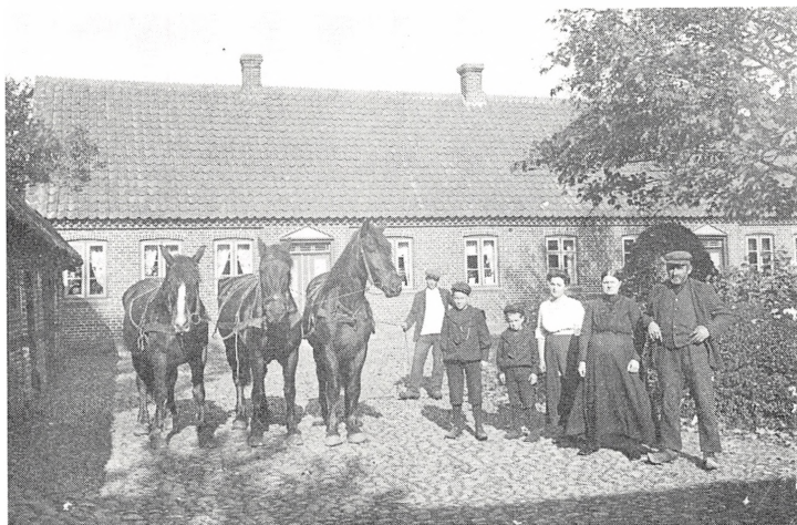
Jens Sørensen (Kjeldsens) gård i Tange - den lå lige ud for Tange station og nedbrødes i anledning af oversvømmelsen. I stuehuset boede ingeniør Andreassen og hustru, mens arbejdet stod på. Billedet menes taget omkring 1912. Fra højre ses ejeren Jens Sørensen, kaldet Kjeldsen, hans kone Maren Kjeldsen, en ukendt tjenestepige, hjorddrengen Charles Thomsen, hvis forældre var ledvogtere ved banen i Tange, andenkarlen Jens Sørensen fra Tange Brohus og forkarlen Jens Kirkegaard. Fotografen ukendt.
