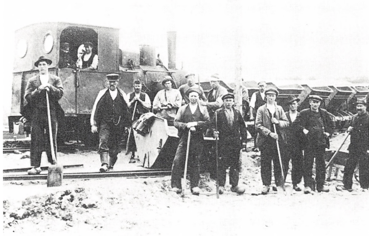
Fig. 24. Tipvognstog og aflæssersjak på hoveddæmningen 1919. Formanden for sjakket står som nr. 2 fra venstre - urkæden understreger ganske godt værdigheden. Omtrent i billedets midte - med overskæg og jernstang i hånden - står Søren Kirkegaard, Tange, som har ydet mange oplysninger til denne bog. Hans arbejde var at tippe læsset af tipvognene, hvortil jernstangen anvendtes. Den passede ind i en bøsning på ladet, og når han og to mere fik deres stænger anbragt her, kunne de vippe ladet, så læsset faldt af. Når balancepunktet nåedes, skulle der holdes igen for at hindre vognen i at ryge af sporet - det arbejde var farligt, og mere end én gang er en arbejder blevet kastet op i luften herved, men ingen vidtes at have taget alvorlig skade. Nu og da dumpede en tipvogn alligevel ned i opfyldningen, da man var tilbøjelig til at lægge sporene så nær kanten som mulig for at formindske arbejdet med flytning af jorden med skovle bagefter. Det skete der ikke andet ved, end at fortjenesten blev mindre den dag, for man arbejdede på akkord og fik betaling for hver tømt tipvogn. Fotoet tilhører Søren Kirkegaard. Ukendt fotograf.
