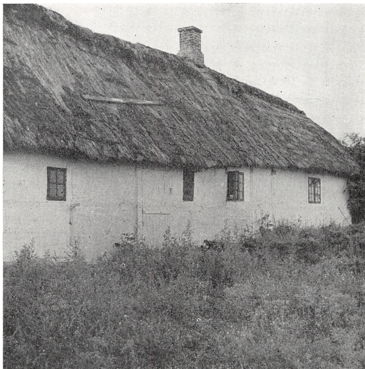
Matr. 41 a. I 1828 fik Zier Larsen Friis »det på gårdstedet etablerede hus«. Gårdstedet var gård nr. 7, hvis jorder blev lagt under Nagelsti Skovgård. Skråstiveren i bindingsværket røber, at »det etablerede hus« når fra det lille vindue til venstre til og med det tolvruddede vindue til højre. Begge ender er senere tilbygget. De smårudedede vinduer fra 1700-årene taler for, at materialer fra den nedbrudte gård er anvendt
