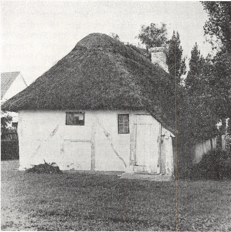
Matr. 37 a. Hus fra 1820 med valmgavl og udsæt, jernalderhusets efterkommer. Lidt bredere, men i bygningsprincippet det samme som for 2000 år siden.
