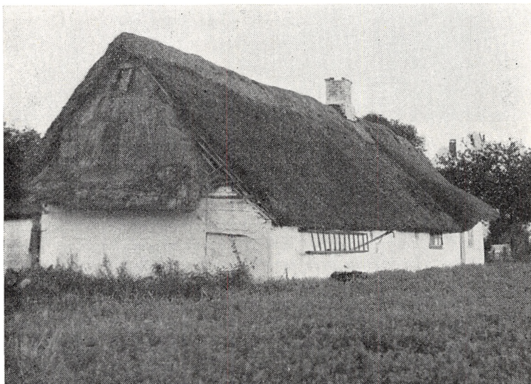
Matr. 42. Opført omkring 1820 på tomten efter gård nr. 10. Tækket nordgavl, udsæt i vestsiden. På udsættets væg i ly under tagskægget hænger brandstigen og brandhagen; — et snart forsvundet træk i landsbybilledet.
