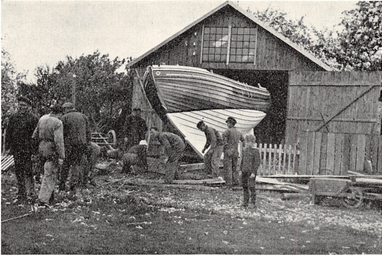
Lystjagten »Solstraale«, konstrueret af og bygget til civilingenør Knud E. Hansen 1939. Jagten trækkes ud af værkstedet før søsætningen.
