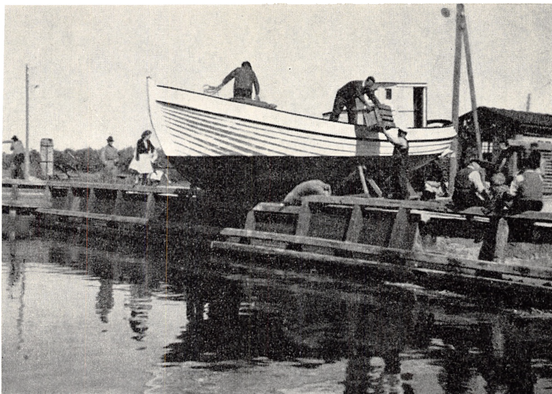
Søsætning af fiskebåd »Vira« af Skalø i Fejø havn 1948. Båden gøres klar til afløbning på »nordre slæbested«; bommen er fjernet, og et par sække med høvlspåner er anbragt på brohammeren for at beskytte båden ved eventuel krængning. — Fot. fru skibsfører Christensen.
