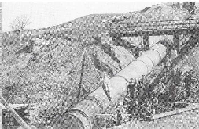
Fra arbejdet ved Harteværket.
