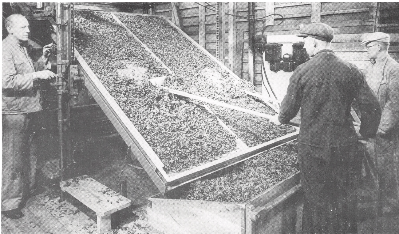
Tørreovn med tørrede cikoriesnitter til produktion af kaffeerstatning, 1943.
