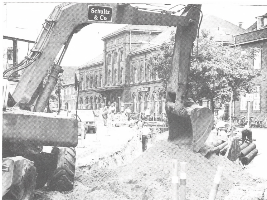
Gravearbejde for TVIS i Jernbanegade juli 1986. (Foto: Ludvig Diltmann).
