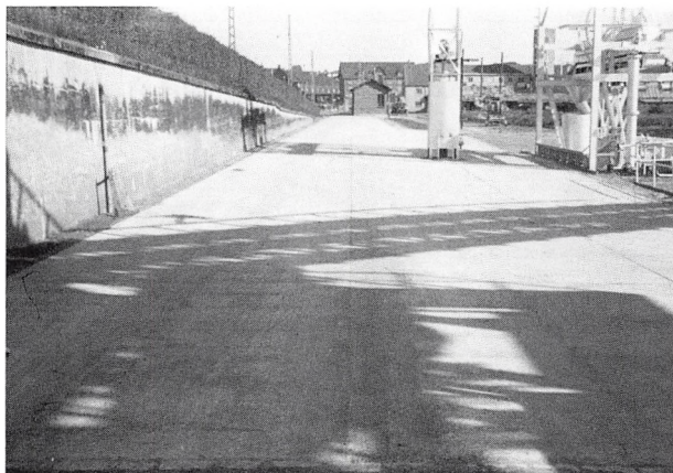
Til højre i billedet ses tippegruben. Til venstre for den ses et jernstativ. Det er en del af hejseanlægget for tipping af roevognene. I tippegruben ses en stor jernspand, der er en del af den automatiske roeprovningstagnation. Spanden befandt sig nede i gruben, når vognene blev tippet og tømt for roer. (Foto: H.C. Ervald, 1950)
