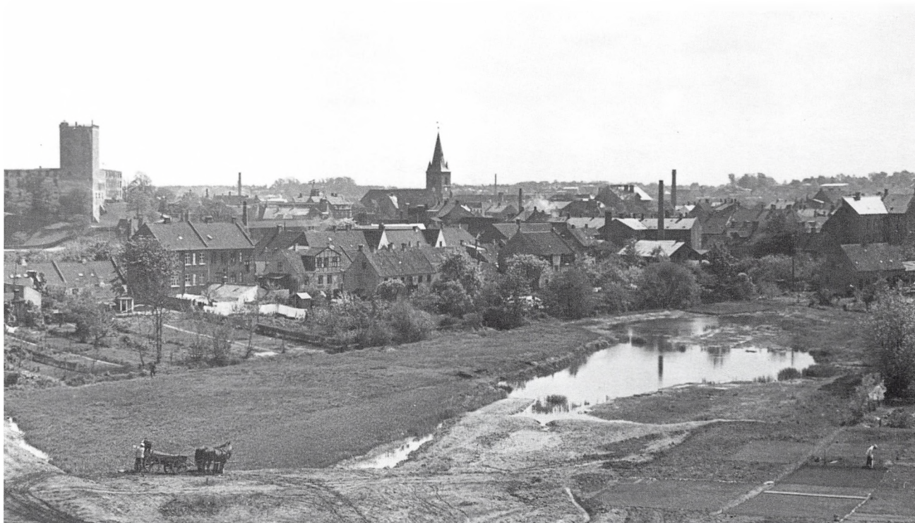
Vifdam under opfyldning.
