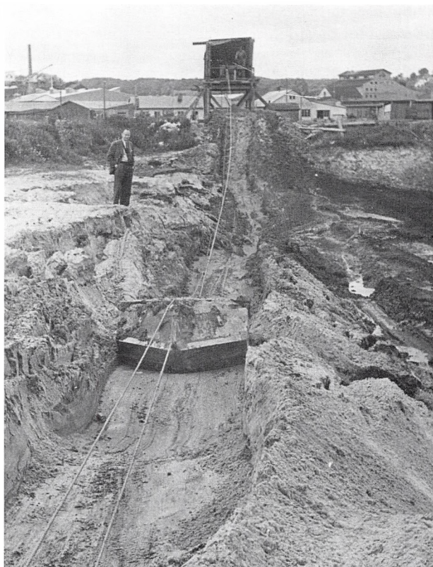
Fylden trækkes op på slisken og falder ned i tipvognene. Til venstre ses H. C. Ervald. (Foto: P. Thastum, 1951)
