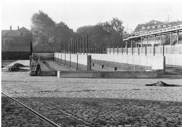
Det færdige roemagasin. Tippegruben for dette magasin blev først udført i 1953. Til højre i billedet ses roemagasin nr. 1, som blev udført i 1949. Oven over magasin nr. 1 ses transportbåndet fra tippegruben. (Foto: H.C. Ervald, 1952)
