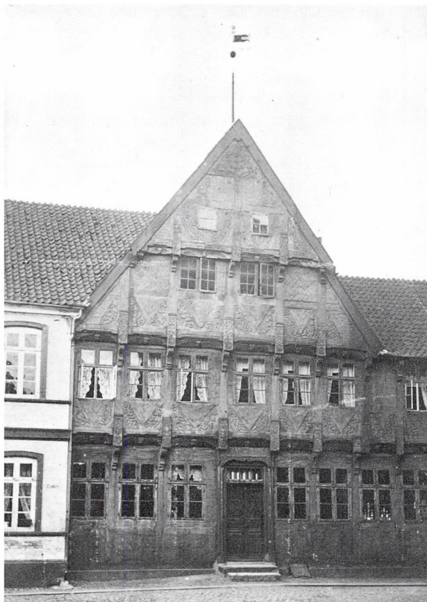
Apoteker Reiminchs gård på Axeltorv er bygget i 1595. Herman Reiminch var indvandrer fra Westphalen, og han havde fra sin hjemegn medbragt skikken at lade bindingsværket udsmykke med rige udskæringer. Fot. af J. Caprani fra 1870'erne.
