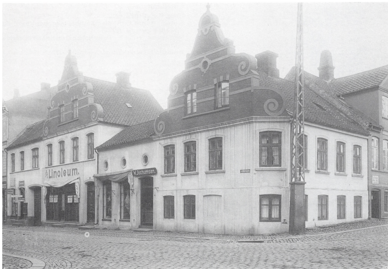
Gavthus på hjørnet af Jernbanegade og Fredericiagade, hvor nu biblioteket ligger. Man ved ikke, hvem der byggede de to huse med vælske gavle, men mon ikke genboen C.F.Holm er en nærliggende mulighed? Foto fra 1918.
