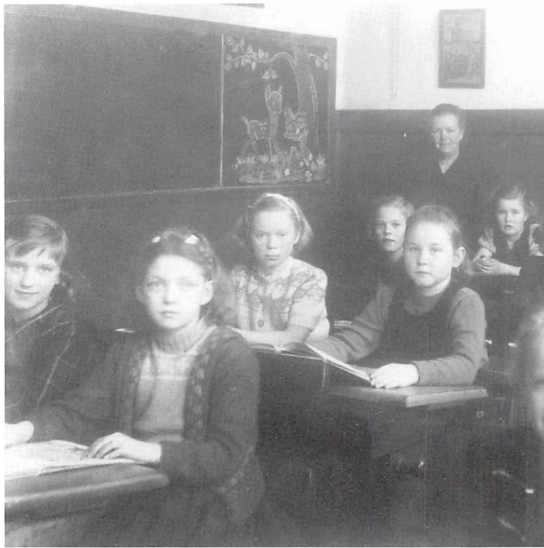
Tavle på Kolding Døtreskole. Foto fra 1930'erne. Stående lærerinde fru Larsen. Tavlen er formentlig fra den tid, hvor tavleoverfladen blev sømret direkte op på en pudset væg, hvorefter den blev indrammet med en træprofil.
