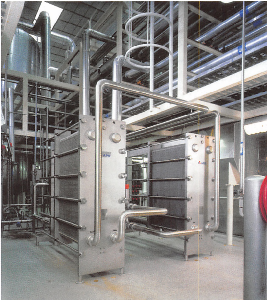
Pladevarmevekslere for høje kapaciteter. Her installeret i bryghus for køling af ølurt. Kapacitet 2x75000 liter pr. time.
