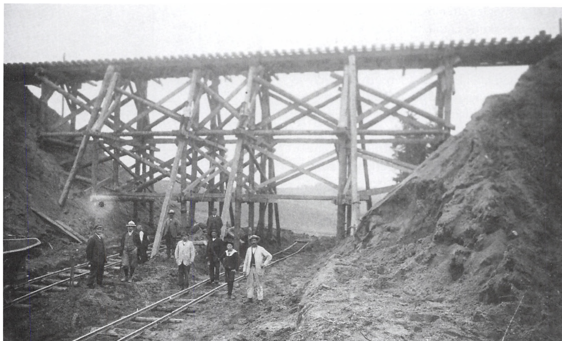
Udgravning til Troldhedebanen under Egtvedbanen i Bramdrupdam, 1915-1916.
