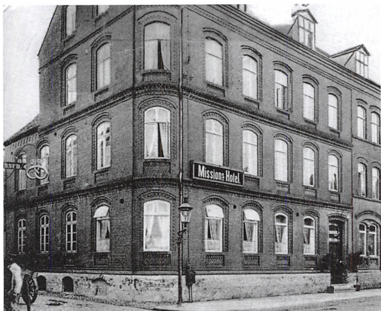
Missionshotellet i Klostergade 26. Ved ombygningen i 1912 fik hotellet en ekstra etage og porten blev muret til, hvorefter adgang til gården foregik gennem Klosterstræde i venstre side af billedet.
