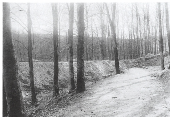
Trolldhedebanen føres gennem Kolding skov. Øverste foto før anlæggelsen, det nederste fra 18. april 1915.
