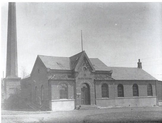
Kolding Vandværk på Stadionvej kort efter opførelsen.
