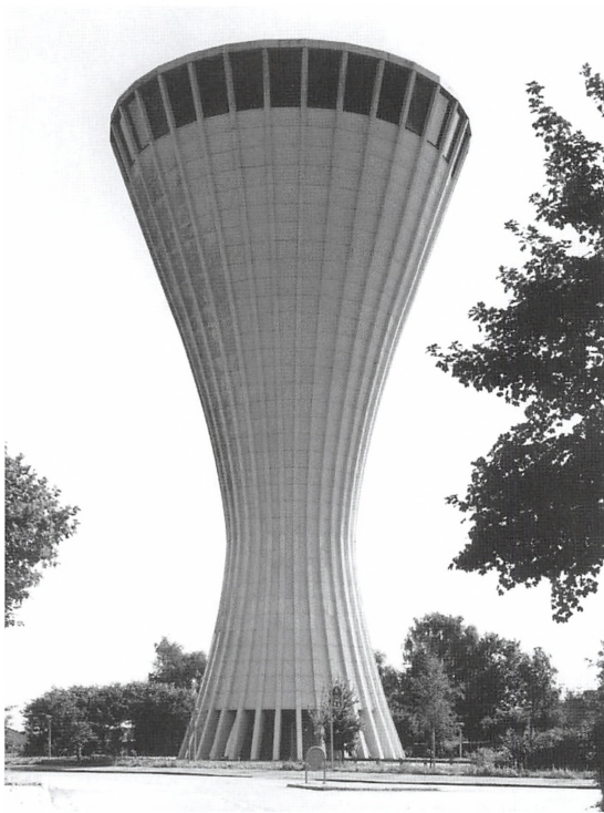
Østre Vandtårn på Sjællandsvej fotograferet i 1992 af Åge Lund Jensen.
