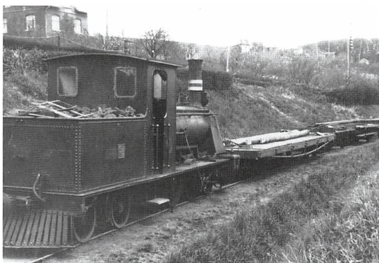
Egtvedbanens spor tages op på strækningen mellem Statsbanegården og Nordbanegården i efteråret 1930.
