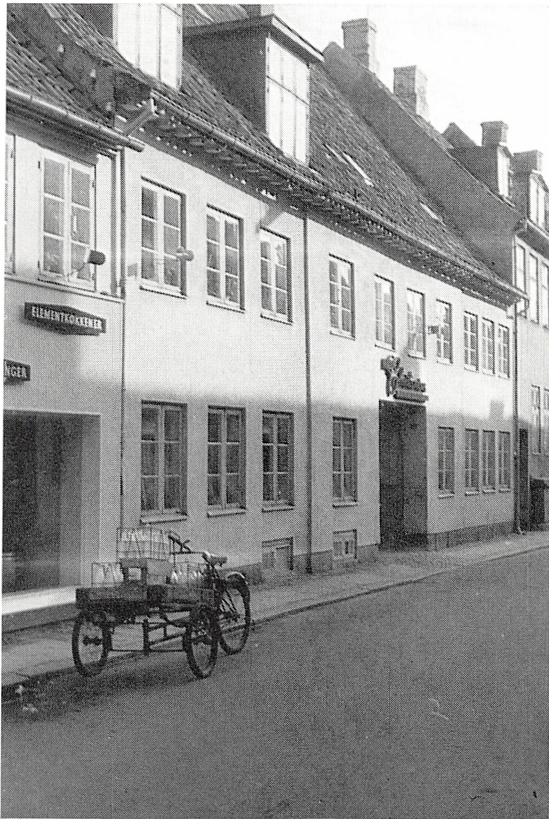
Fig. 17. »Jærgaardens«, nr. 513 i Sudergade (nuv. nr. 13), indtil 1798 militært sygelhus. Facaden ombygget fra bindingsværk til grundmur mellem 1798 og 1801. Husets facade har i sin proportionering adskillige sællestræk med vort teater. — Pough kan have været murermester for facadens ombygning; hans egen gaard laa kun to huse fra dette hus. F. C. Tegners hus ses t. v. for huset. Forf. Fot. 1964.
