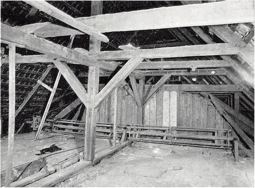
Fig. 8. Fra sceneloftet. I forgrunden sprængværkets ene »konges«, der fortsætter til kippen (spærenes toppunkt). I baggrunden fortæppets vinde og gavlen af salens tøndehvælving. N. Elswing fot. 1956. — Jvf. »Den gamle By«s aarbog 1961, s. 42.
