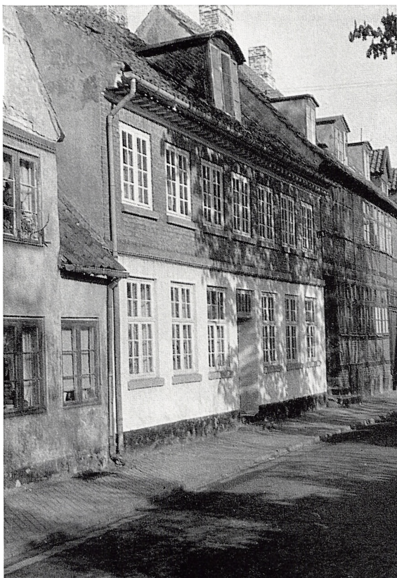
Fig. 15. Murermester Poughs hus i Sct. Annegade nr. 165 (nuv. nr. 39). Købt 1809 som et en-etages hus med kvist. Facaden ombygget til grundmur i to etager mellem 1811 og 1817. 2. sals puds maa senere være afhugget. Forf. fot. 1964.
