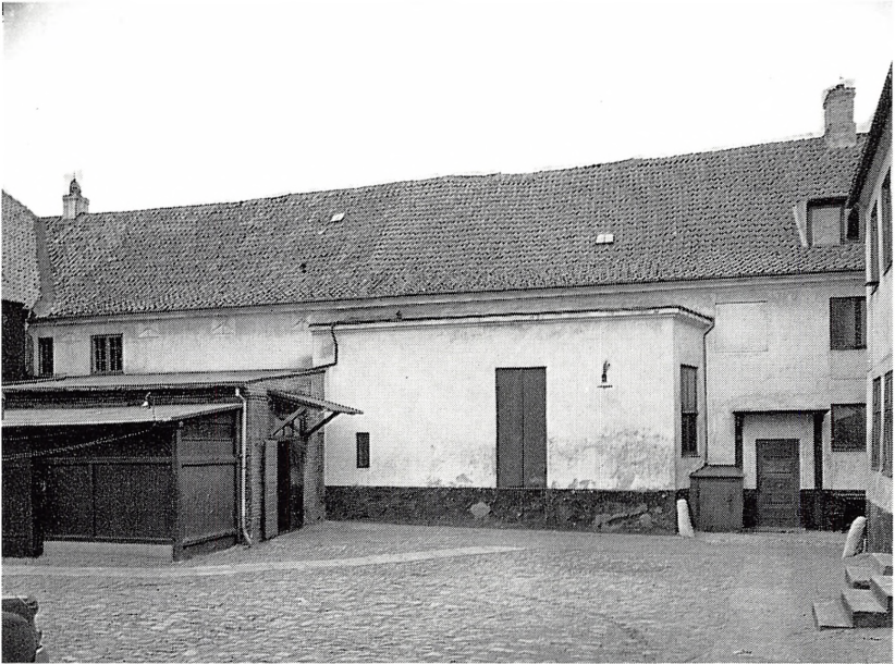
Fig. 3. Teatret set fra gaarden. Midt for kulissebygningen fra omkring 1846. T. v. herfor den lavere tilbygning fra 1896, parkettets restauration, og længst t. v. den to-etages bygning, der gik vinkelret ind paa teatret ved dets nordlige ende. N. Elswing fot. 1956.
