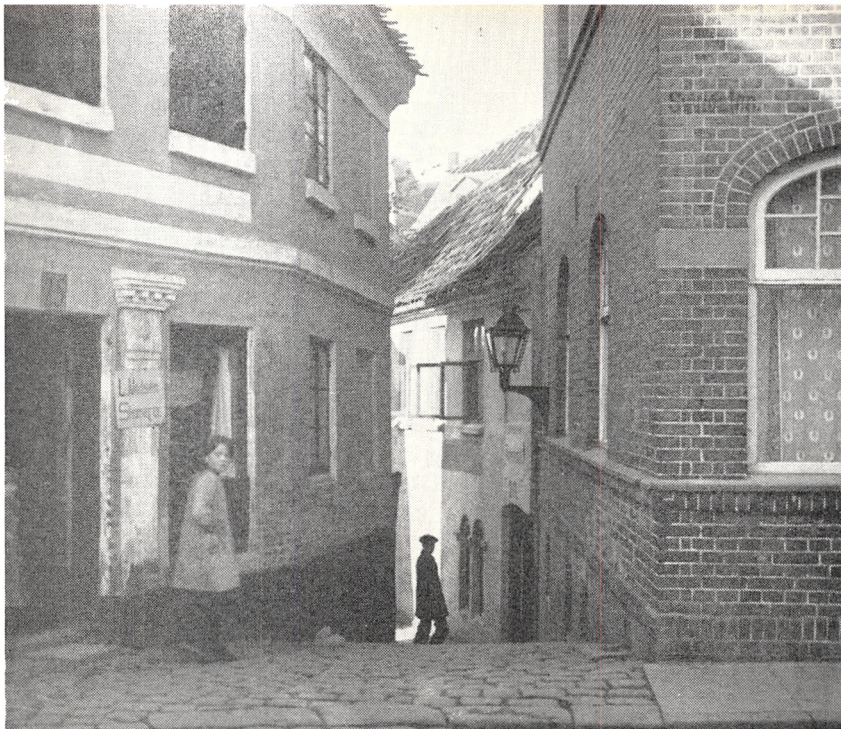
Mestermannens Gyde eller Schjellerups Gang set fra Skole- gade mod vest. Svingelen er til højre.
