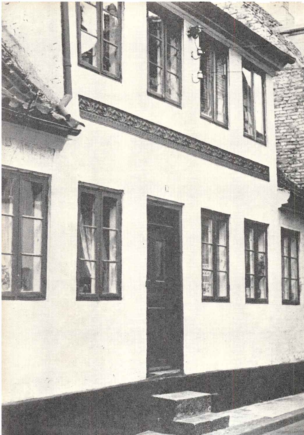
Store Nygade nr. 16 var gadens smukkeste hus. Det var lysegråt med en grøn palmetfrise under kvistvinduerne.
