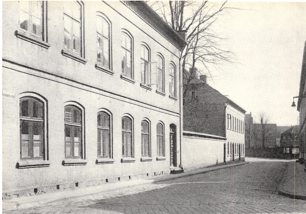
Frisenborg set fra vest. Gaden gik kun til lysstriben, der markerer Fjordgade. I bygningen til venstre var der i en årrække havnekontor. I baggrunden ved de store træer fandtes Den lille Ekserserplads med ekserserhuset.
