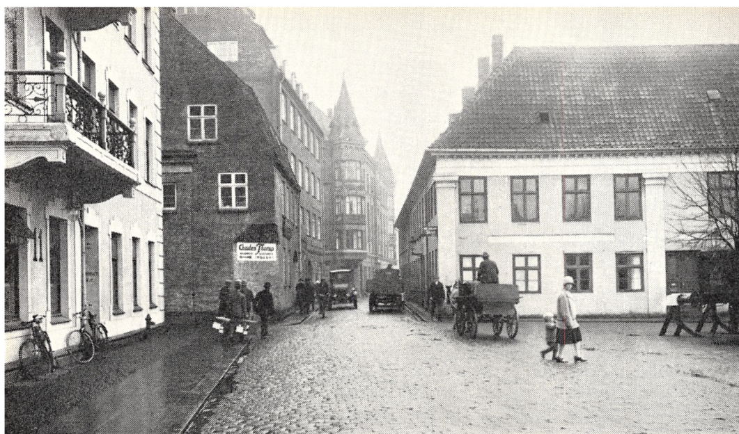
Billedet viser fra venstre Ved Stranden nr. 11, hvor Smutten fandtes ved gavlen. Midt for Stormgade, hvor skiltet på hjørnet med ordet Skridt fortæller, at der er fartbegrænsning i denne gade. Til højre det hjørne af »Spritgaarden«, hvor der var politistation fra 1896 til 1916.
