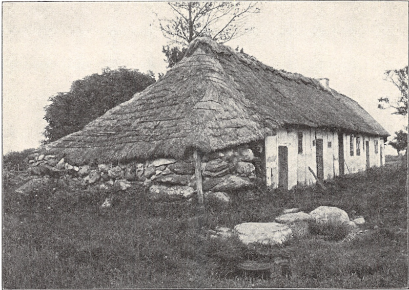
Fig. 2. Huset i Taagense, Østlolland.
