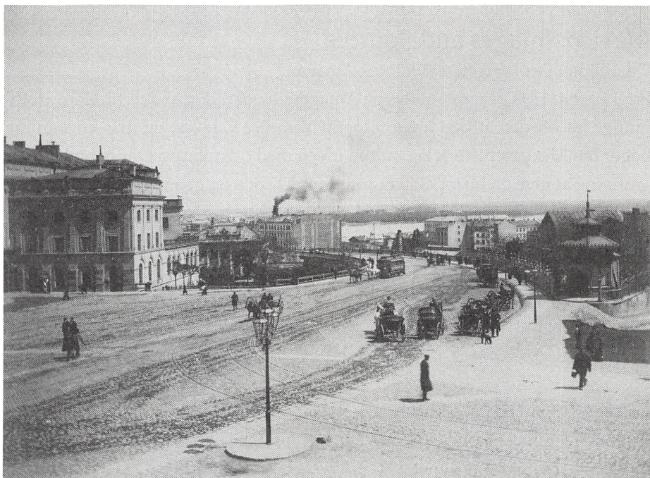
Indkørslen til Warszawa, ca. 1885. Fot. Konrad Brandels. - I lighed med billedet på modstående side erhvervet til Kort- og Billedafdelingen.
