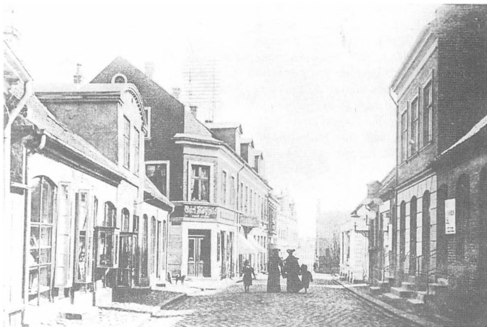
Vestergade set fra vest. Til venstre ses nr. 18 - før ombygningen i 1919 med Marie Badstues galanterivare-butik og udhængsskabe i den vestre halvdel af facaden. Foto 1896-1902.
