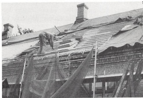
Restaureringen på Viebæltegård: Ikke alene blev mange skiferplader udskiftet, men store partier af gavlene blev muret om og isoleringen af loftsetagene tilendebragt.
